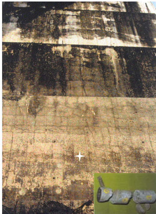
Figure 2 : Dégradations dues à l'alcali-réaction [52].
