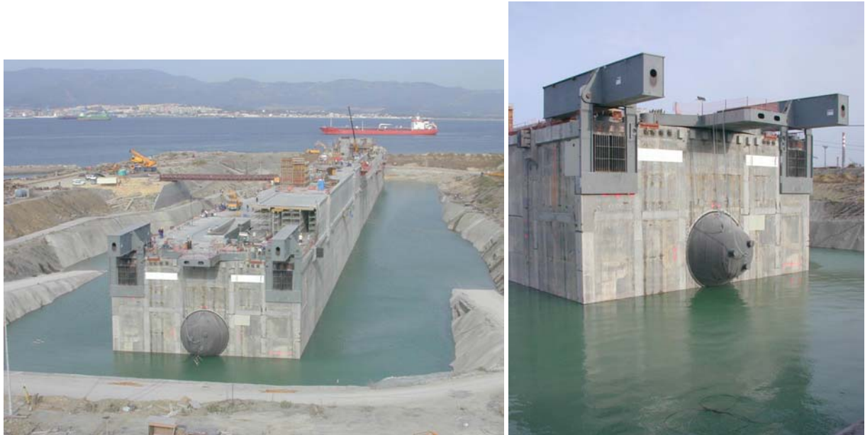
Figure A15.2 : Mise à l'eau de la digue flottante réalisée en Espagne et destinée à l'extension du Port de la Condamine (Monaco, France).
