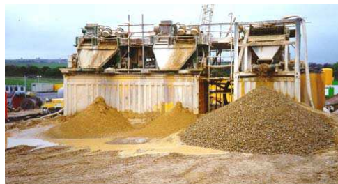
Traitement des déblais
