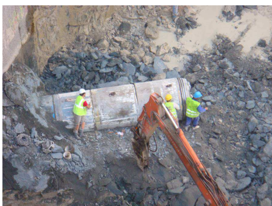
Extraction du microtunnelier dans le puits de sortie
