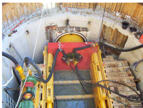
Circuit de marinage en puits
