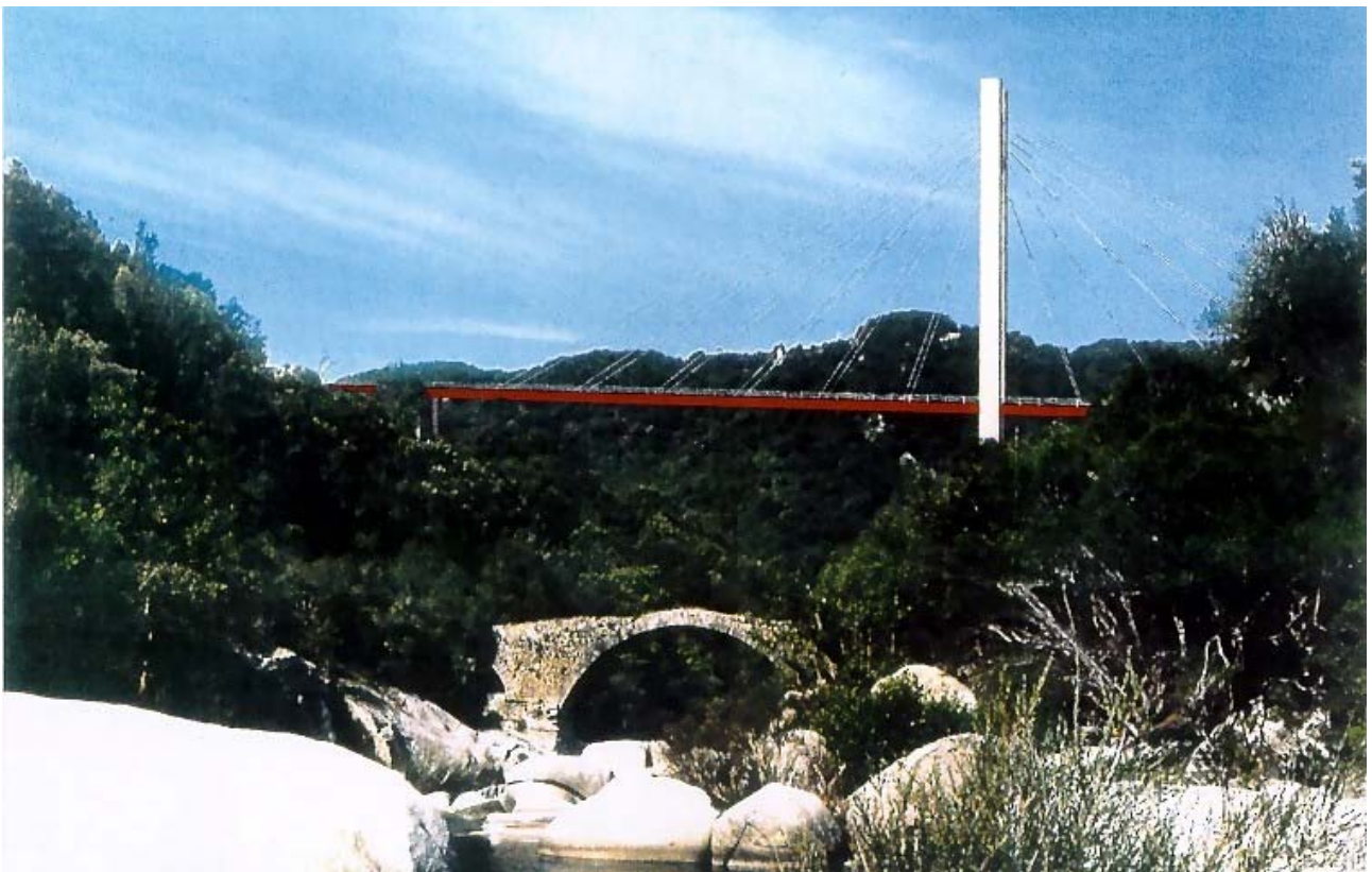
Solution n°2 – Pont à haubans
