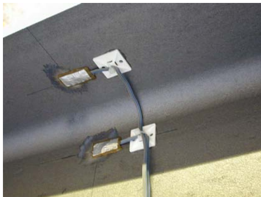
Figure 7: Strain gauges bonded on steel girder surface to monitor the evolution of the deformations. Mesures des déformations du profilé en acier au moyen de jauges.
