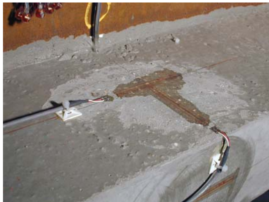
Figure 6 : Mesures des déformations du béton au moyen de jauges / Strain gauges bonded on concrete surface to monitor the evolution of the deformations.
