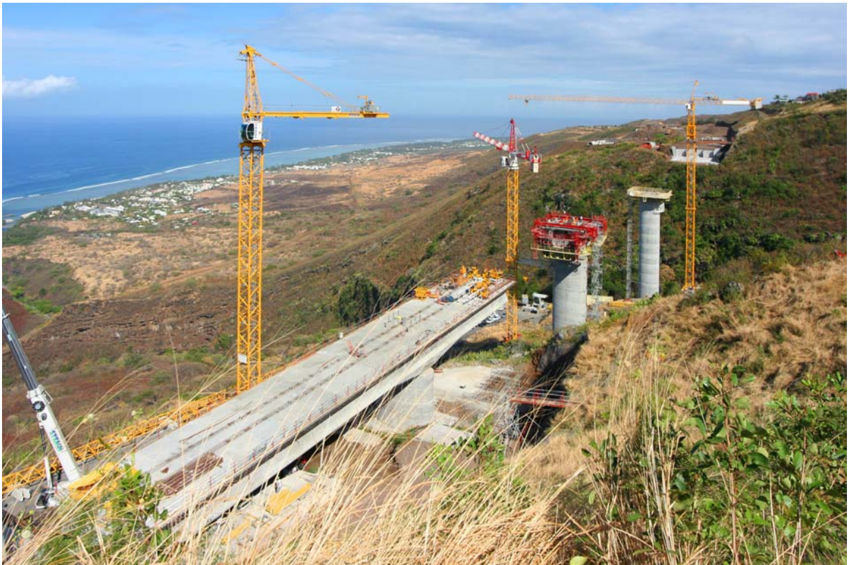
Photo1 – Avancement du chantier en janvier 2008
