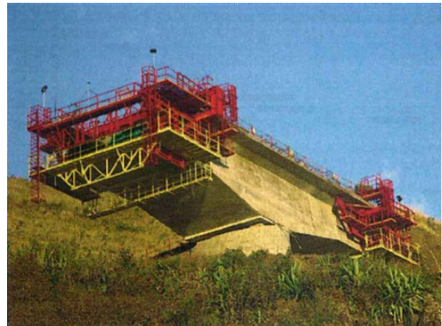
Photo 3 - Equipage mobile sur le fléau P3
