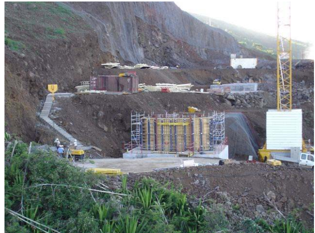
Photo 5 – Coffrage de la pile P3
