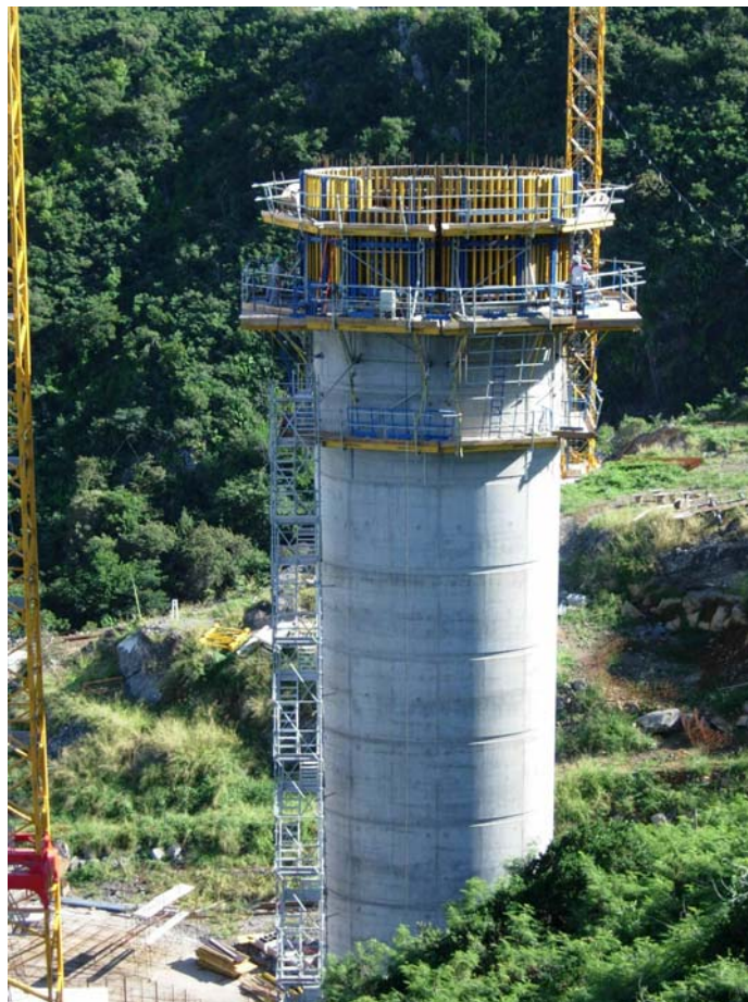
Photo 6 – Coffrage des piles P1 et P2
