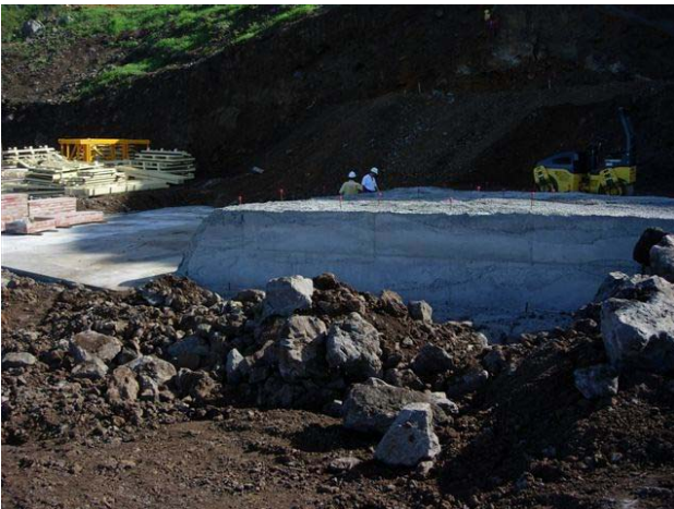
Photo 4 – Béton de substitution sur C4
