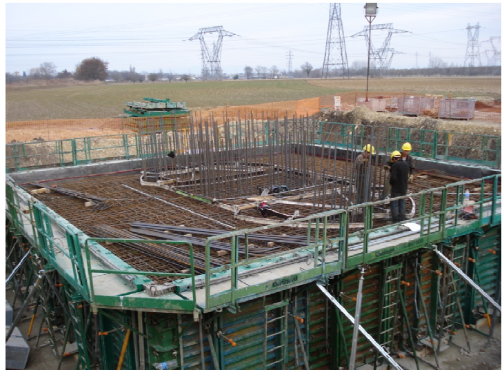
Réalisation des semelles
