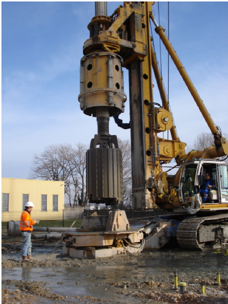
Réalisation des pieux
