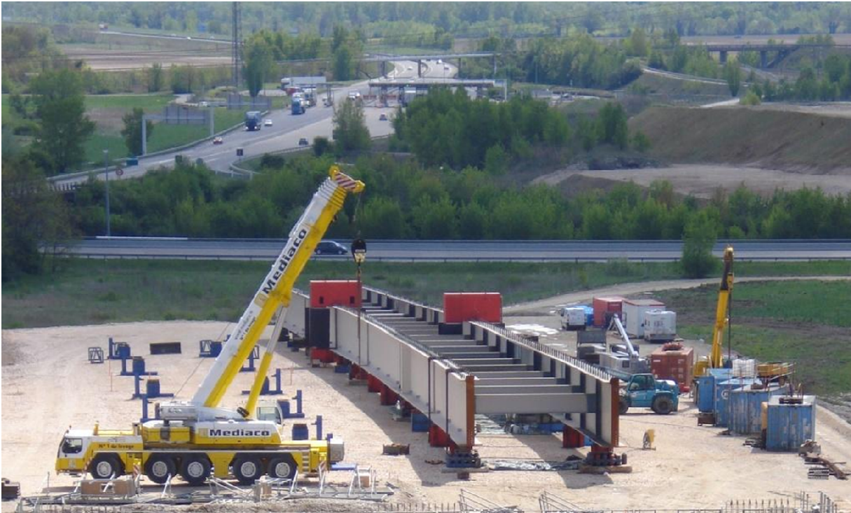
Assemblage de la charpente métallique sur la culée C16
