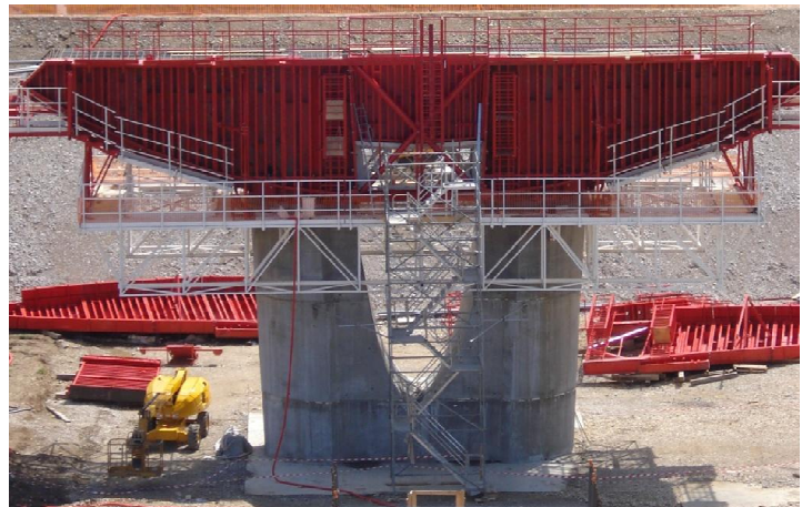
Réalisation des chevêtres de piles
