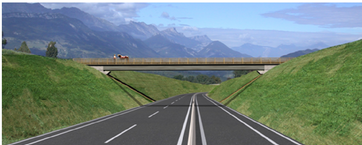
Fig 1 - Vue générale de l'ouvrage / General view of the structure
