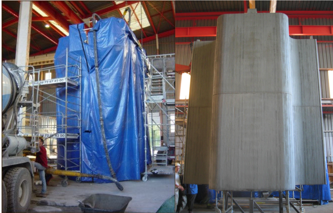
Fig 10 : Fabrication des voussoirs / Segment manufacture
