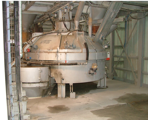
Fig. 5 : Romagnieu precast factory mixer Malaxeur du site de préfabrication de Romagnieu
