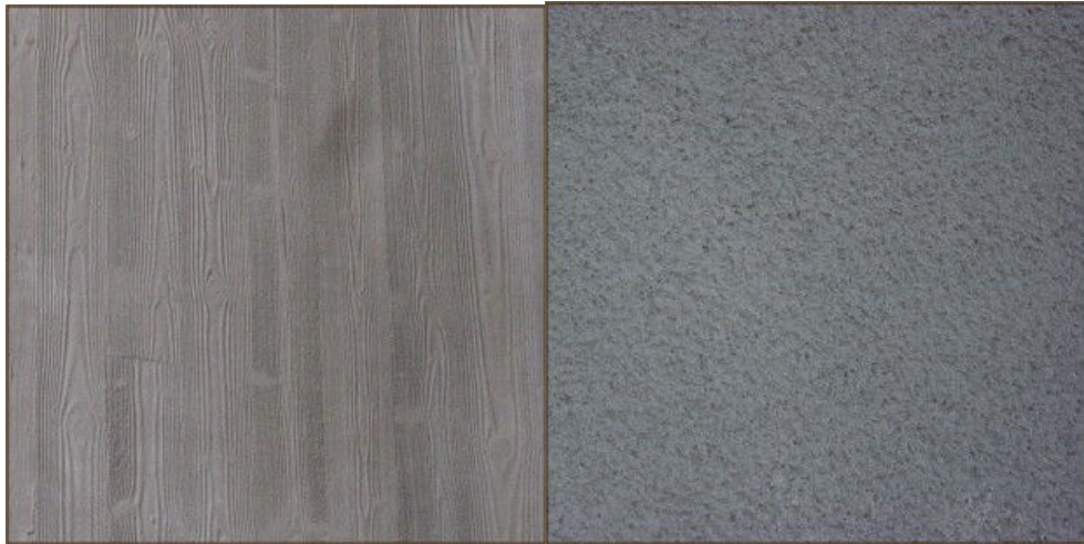
Fig. 8 : Matrice bois et matrice rugueuse d'extrados / Wood and upper slab granular formwork surface
