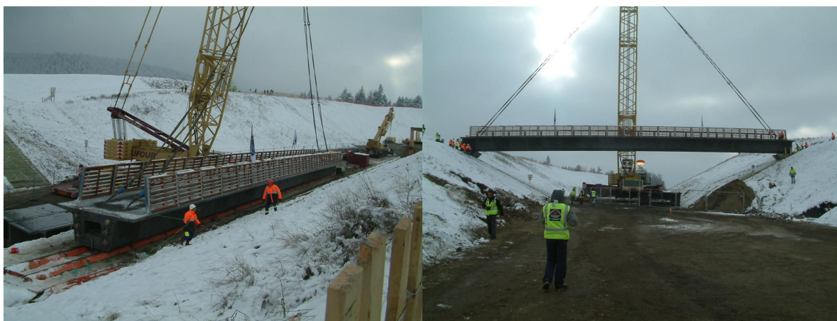
Fig. 12 : Mise en place à la grue / Crane raising
