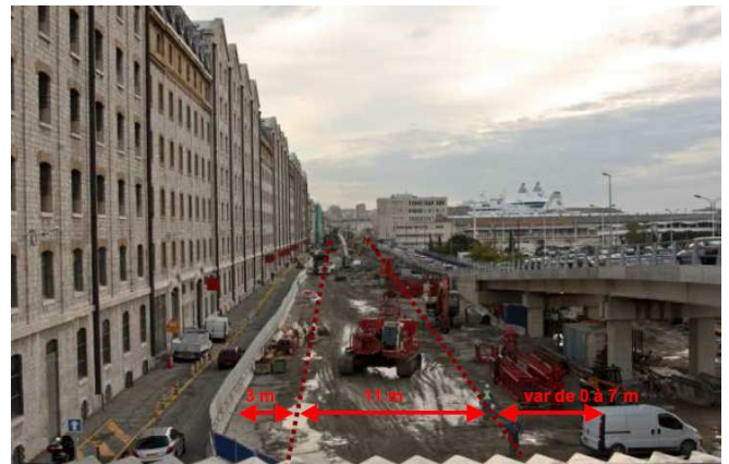
Figure 10: Emprise du chantier
