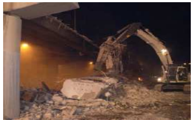
Figure 11: Démolition de l'ancien viaduc pendant la nuit
