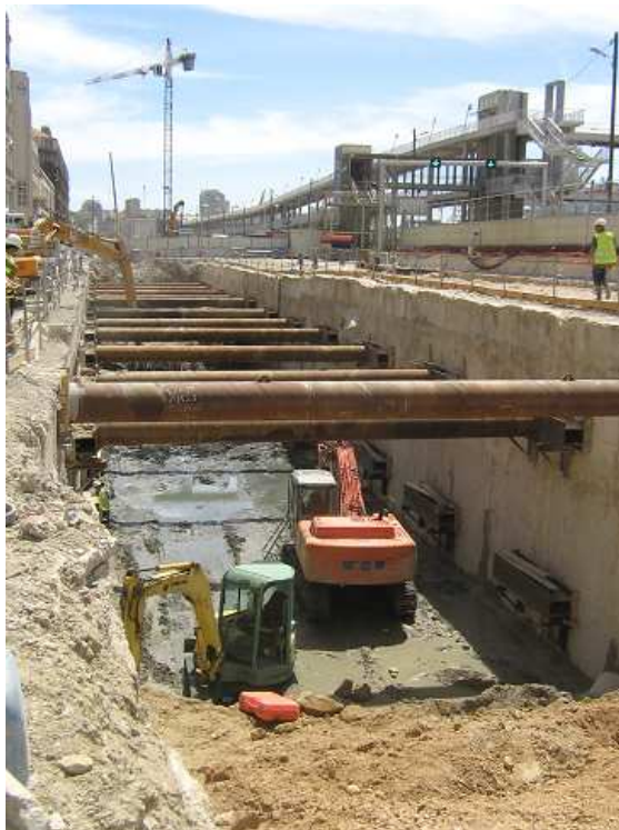
Figure 18: Réalisation à ciel ouvert de la section à 2 voies du tunnel - Vue d'ensemble
