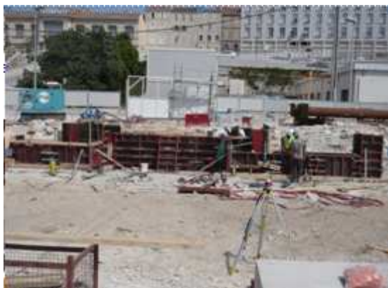
Figure 19: Coulage des parois moulées
