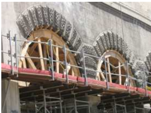
Figure 17: Consolidation des voûtes de la Major
