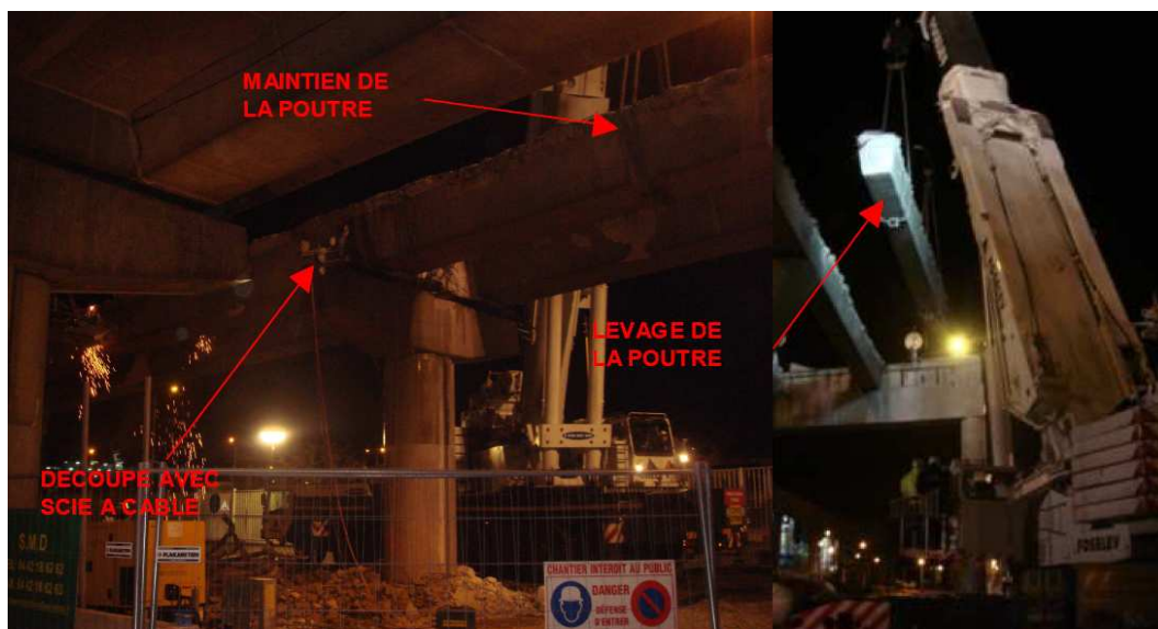
Figure 14: Application du sciage et levage des nervures sur chantier
