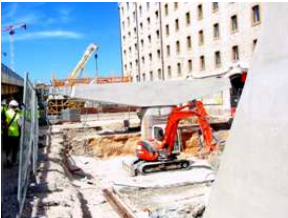
Figure 18: Réalisation du viaduc de descente: pas difficile techniquement mais manque d'espace
