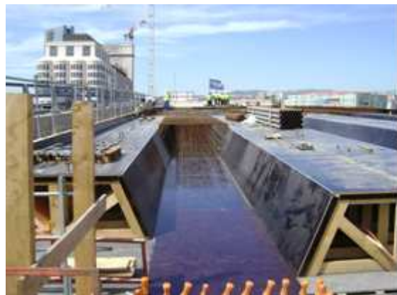
Figure 20: Coffrages et ferrailages des nervures
