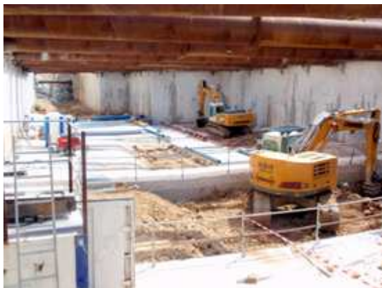
Figure 20 : Réalisation des radiers
