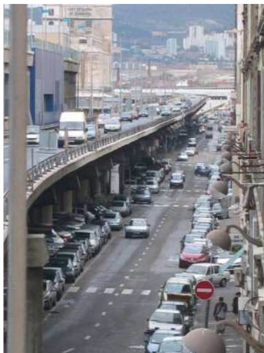
Figure 4: Déviation de la circulation routière: situation avant les travaux
