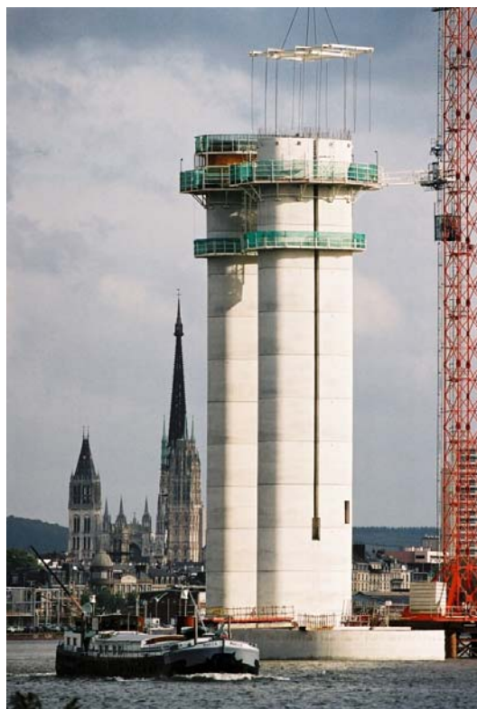
Les pylônes / The pylons
