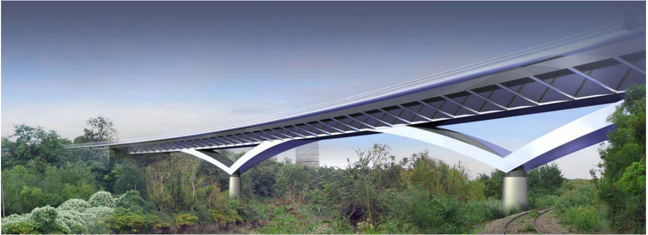
Figure 17 : Le viaduc de l'Orne vue depuis la voie ferrée
