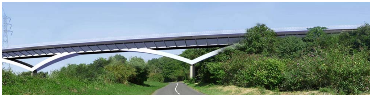
Figure 8 : Le viaduc de l'Orne à partir de la route communale
