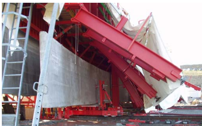
Fig. 9 Removal of control-face segment Evacuation du voussoir
