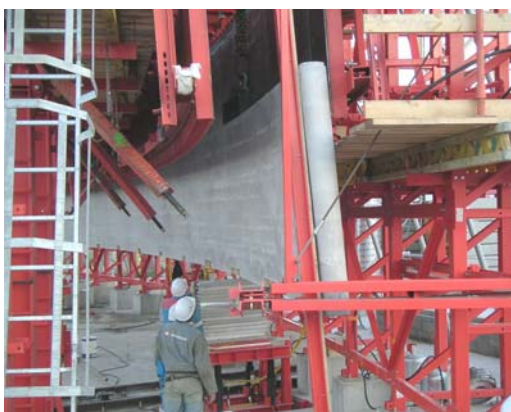
Fig. 8 Voussoir en cours de descente Segment lowering
