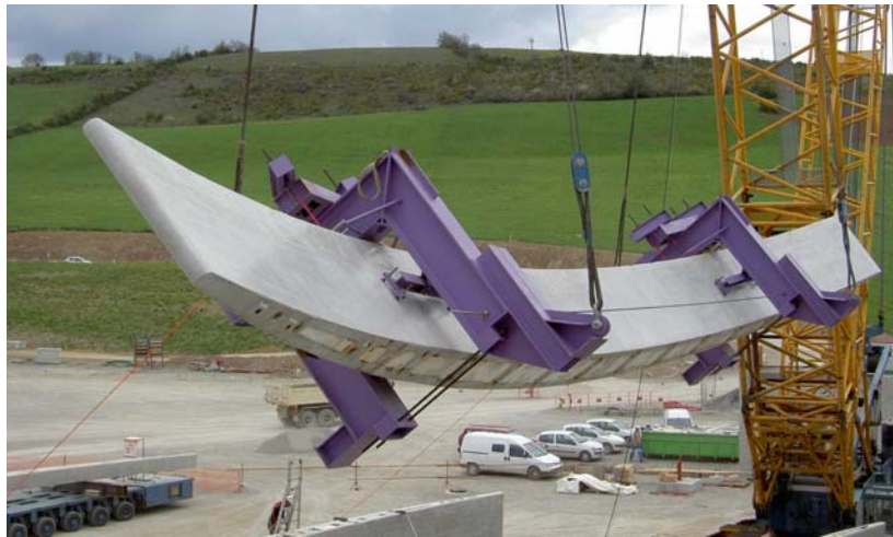
Fig. 10 Levage et retournement d'un voussoir / Hoisting and turning a segment
