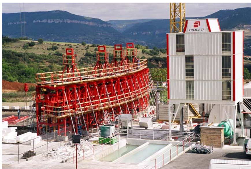
Fig. 7 Cellule de préfabrication / Segment casting yard
