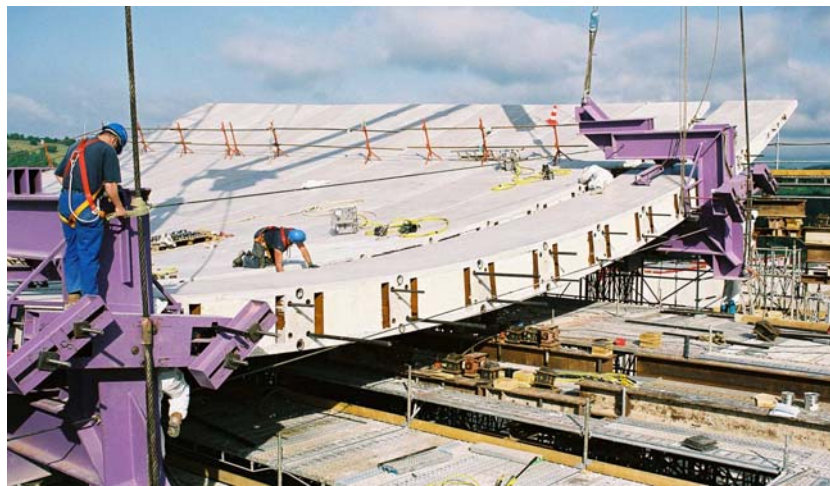
Fig. 11 Présentation d'un nouveau voussoir sur le cintre / Offering up new segment on falsework
