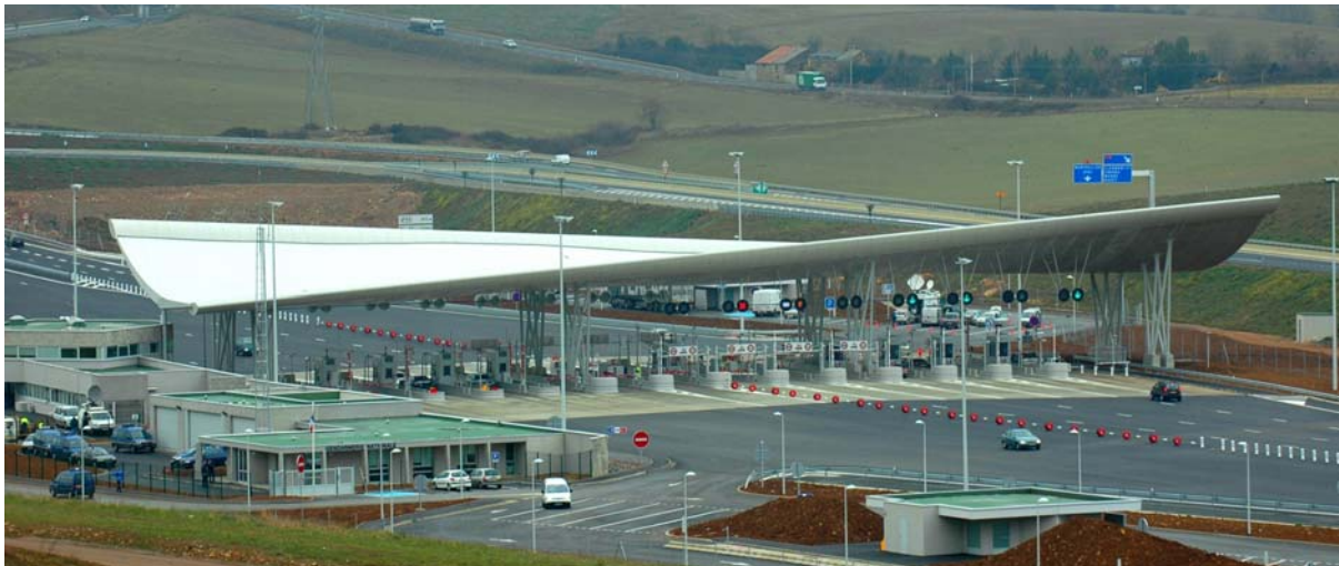
Fig. 12 Mise en service de l'ouvrage le 16 décembre 2004 Toll plaza opened on 16th December 2004
