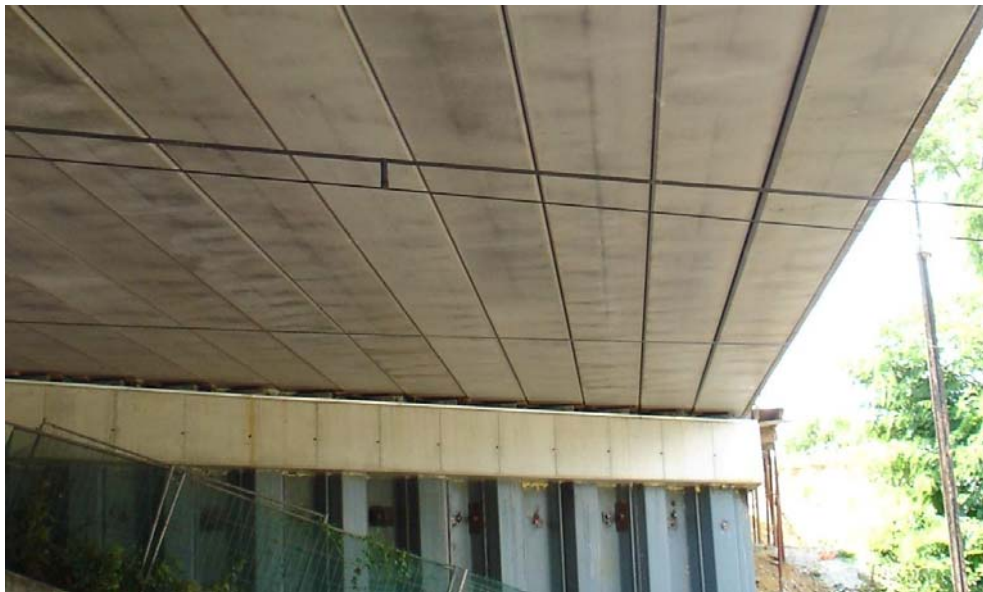
Photo 7 : Sous-face du tablier
