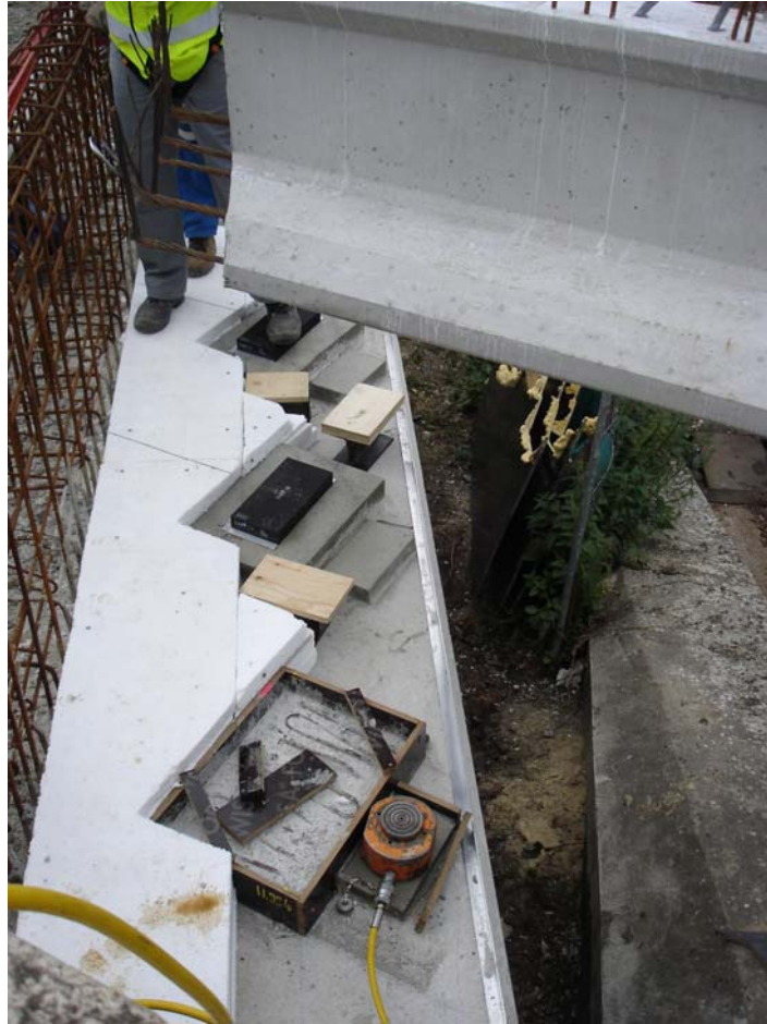
Photo 6 : Cales provisoires pour les poutres de rive
