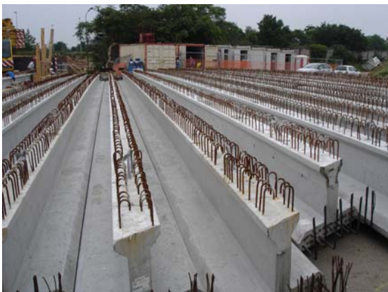
Photo 4 : Stockage des poutres sur chantier
