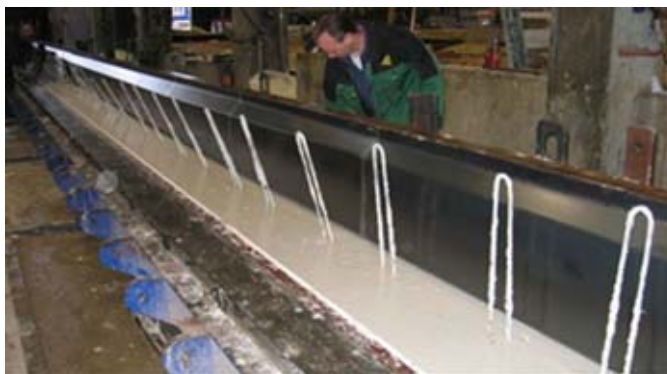
Photo 3 : Mise en place de la partie supérieure du coffrage
