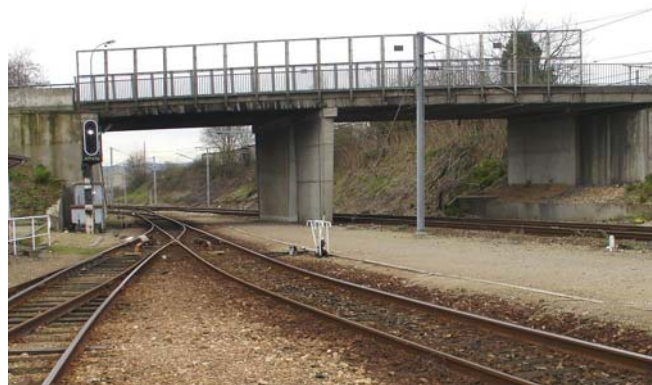
Photo 1 : Vue générale de l'ouvrage existant
