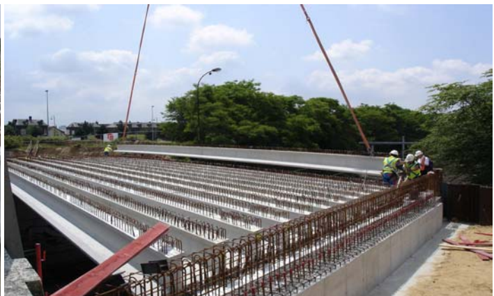
Photo 5 : Pose des poutres
