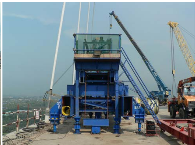
Hissage d'un voussoir (250 t) par équipage mobile. Cet équipage est celui déjà utilisé sur les deux autres ponts haubanés « Industrial Ring Road » voisins qui venaient juste d'être terminés.
