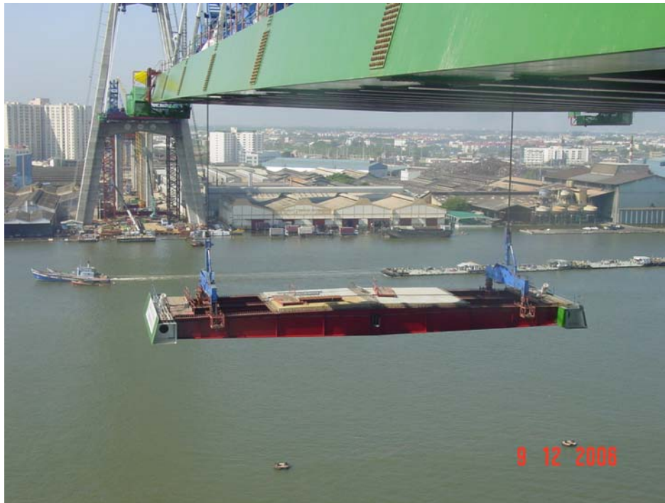
Hissage d'un voussoir (250 t) par équipage mobile. Cet équipage est celui déjà utilisé sur les deux autres ponts haubanés « Industrial Ring Road » voisins qui venaient juste d'être terminés.
