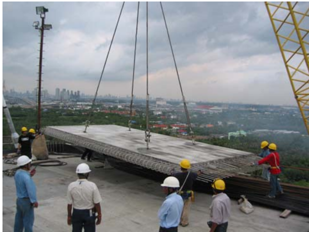
Pose des pré-dalles (25 t chacune) par grue mobile (poids 100 t).
