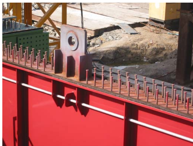
Partie avant de l'équipage mobile en fin de hissing et partie arrière montrant l'accrochage par gros goujons et anneaux en tôles épaisses soudées aux pièces de pont.
