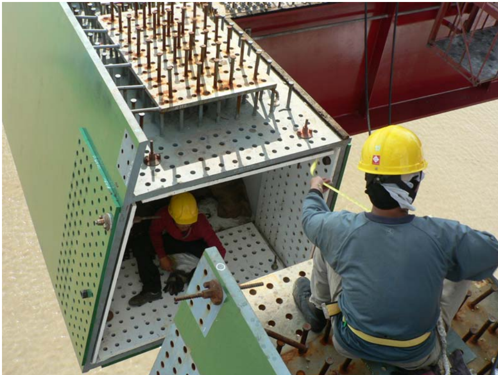
Poutres-caissons de deux voussoirs consécutifs en cours d'alignement
