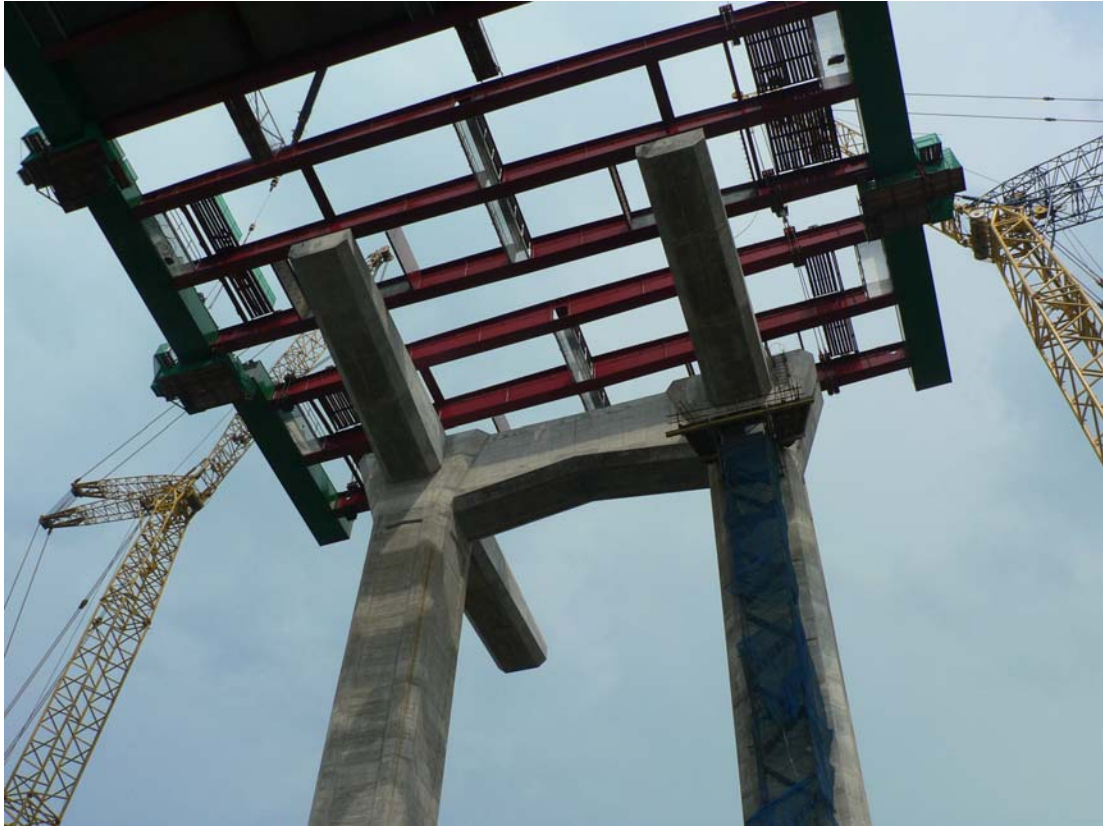
Les charpentes de 2 voussoirs sont posées à la grue sur les marteaux des piles, puis boulonnées entre elles et à l'extrémité du fléau.
