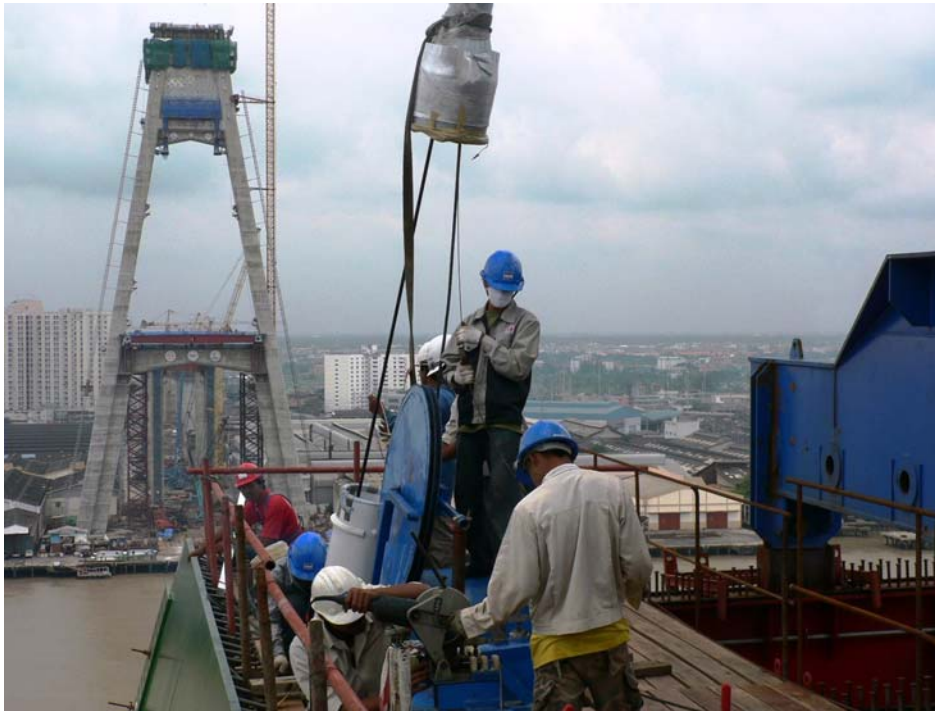
Enfilage des torons un par un
