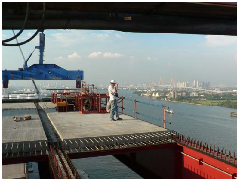
Vue d'ensemble des pré-dalles avant clavage.
