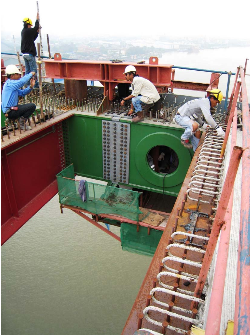
Clavage des poutres latérales après mise en place d'une fourrure de 200 mm (fabriquée au dernier moment).
