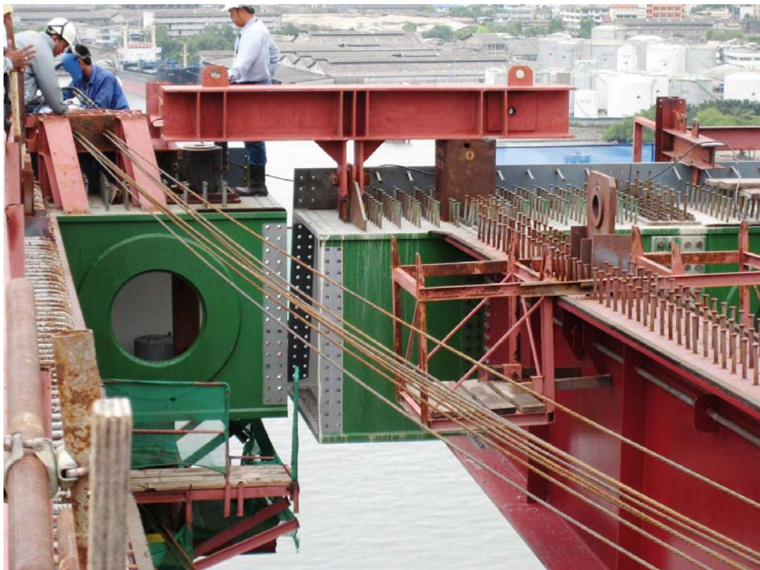
Systèmes d'alignement horizontal - câble « oblique » en plan et vertical (vérinage d'un côté sous une « potence » ancrée de l'autre).
