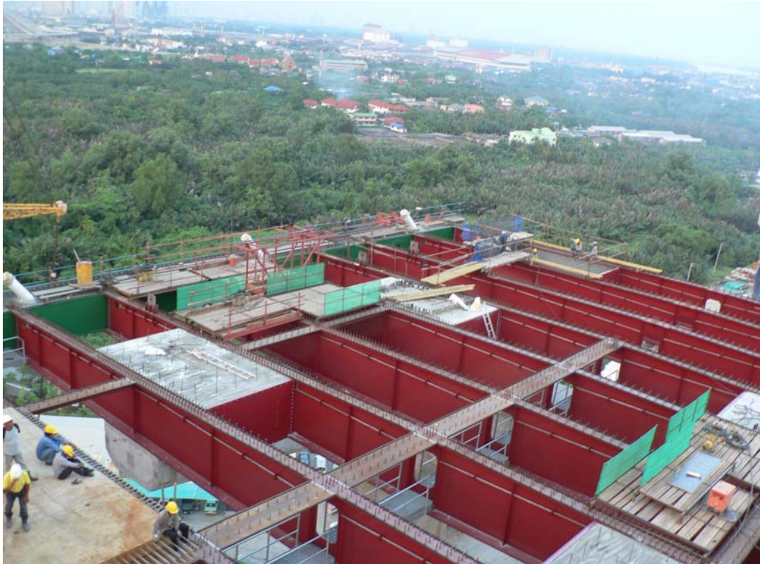
Les contrepoids sont bétonnés et les pré-dalles posées.
