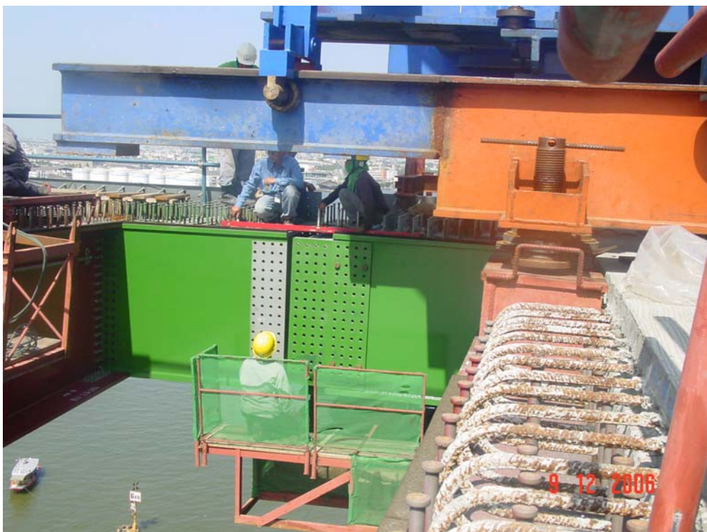
Poutres-caissons de deux voussoirs consécutifs en cours d'alignement
