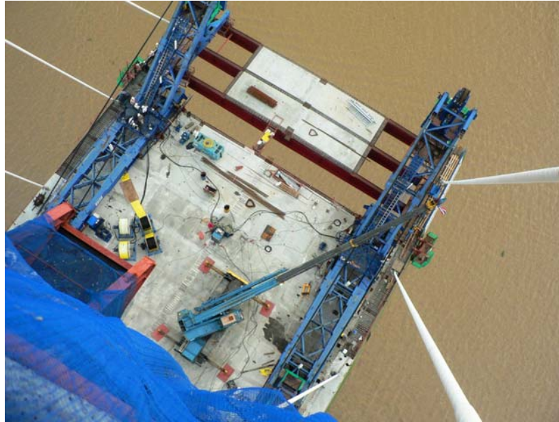
Boulonnage terminé ainsi que la première mise en tension des haubans.
