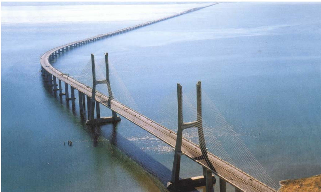
Figure 1. Le pont sur le Tage à Lisbonne. Vue du pont à haubans. (Photo Vinci Construction extraite de [3])
