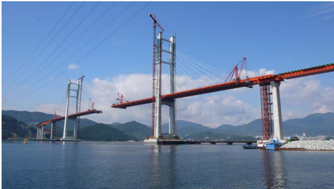
Vue générale de l'ouvrage en octobre 2007
