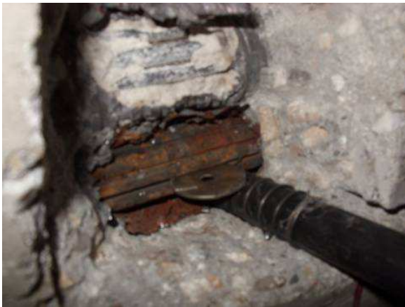
Réinjection des gaines vides
