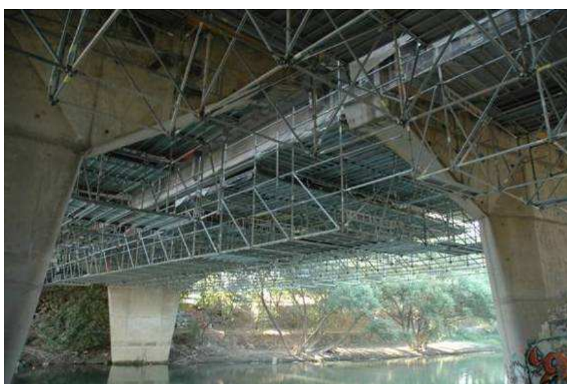
Vue d'ensemble de l'échaffaudage
