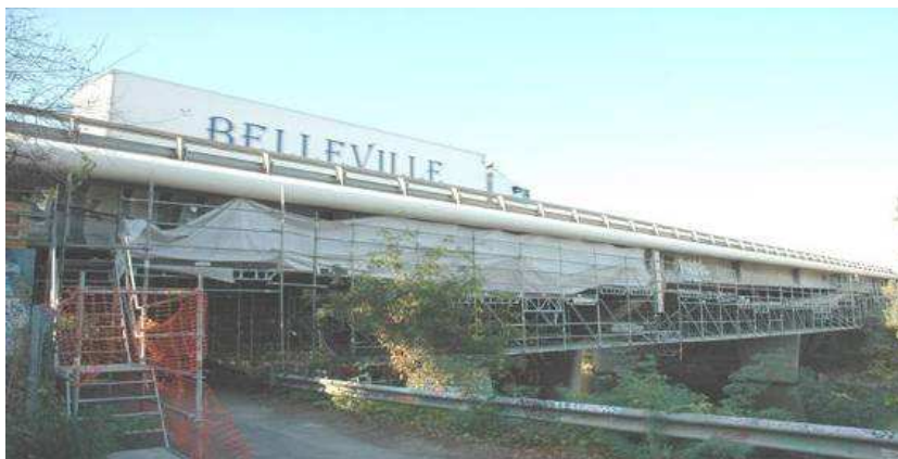
Vue d'ensemble de l'échaffaudage
