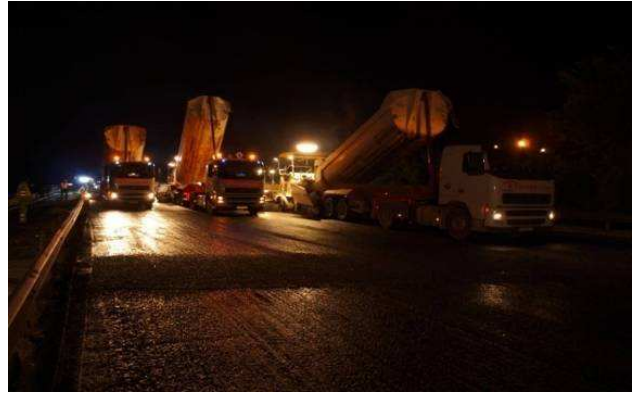
Travaux de nuit
