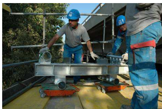
Pose des déviateurs
