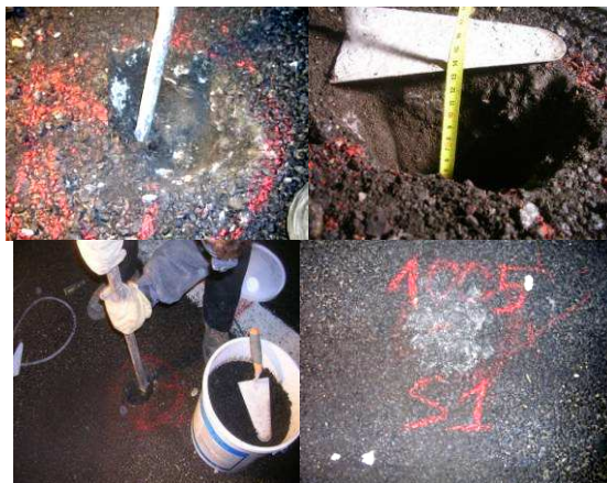
Réalisation de deux sondages destructifs (1 par tablier) pour étalonnage des mesures Radar
