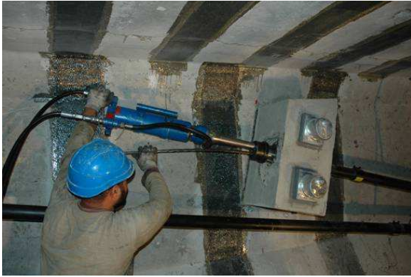
Mise en tension
