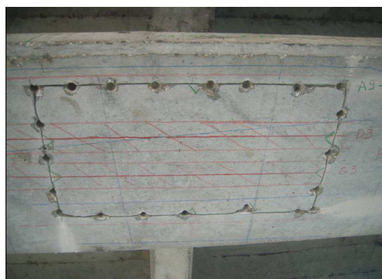
Trait de scie et forage à une profondeur fixe
