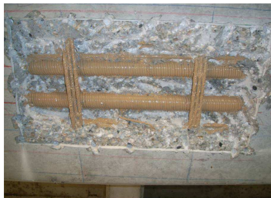
Passivation des gaines et des armatures
