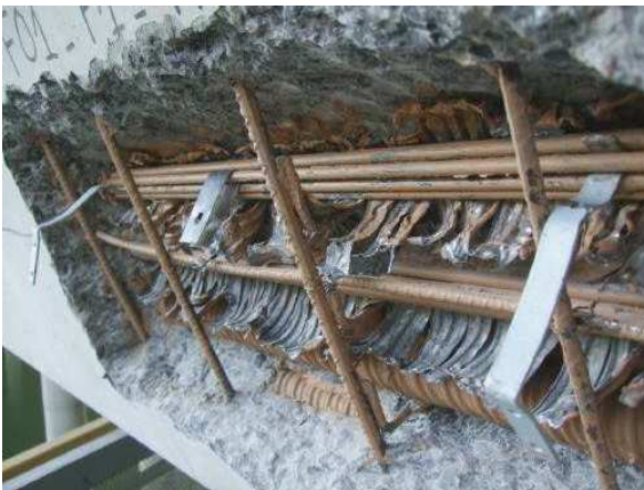
Mise en place écarteur et fourchette
