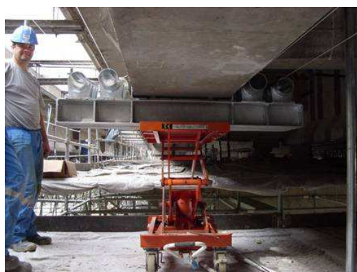
Pose des déviateurs
