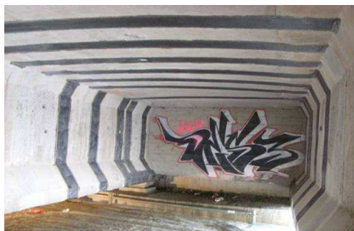
TFC sous abouts de poutres et sur hourdis
