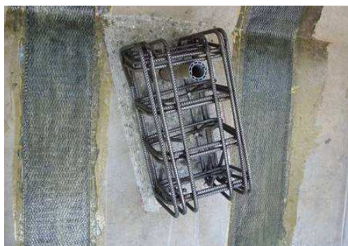
Réalisation des blochets
