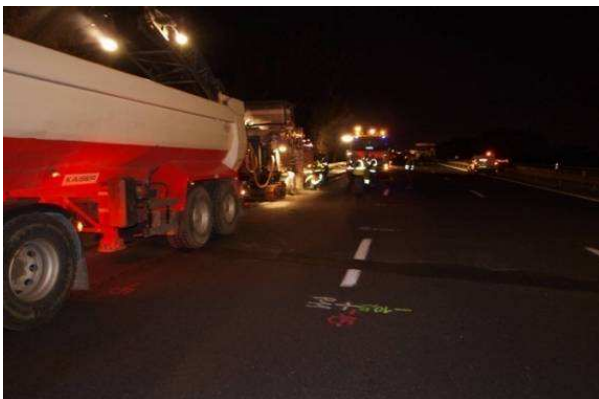
Travaux de nuit
