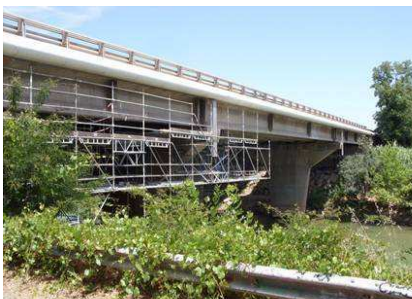
Vue d'ensemble de l'échaffaudage
