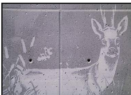
Parement béton en BAP
