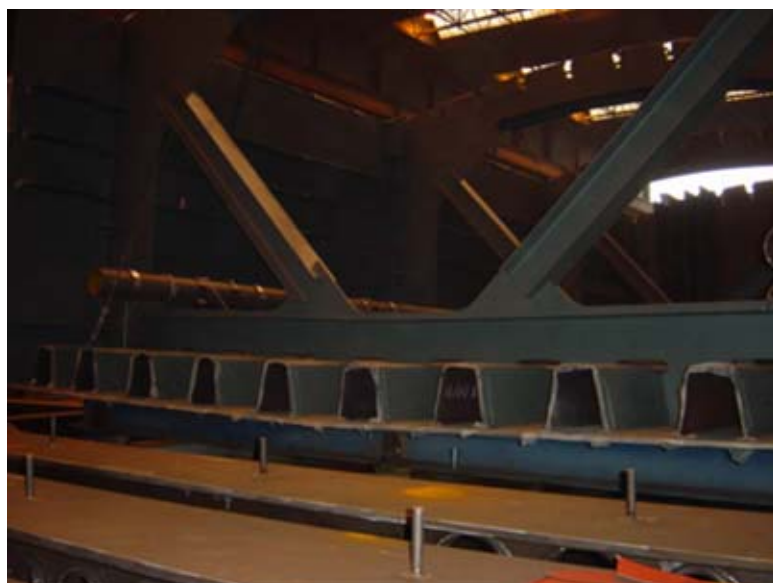
Photo 1 : Vue (retournée) du raidissage interne du tablier
