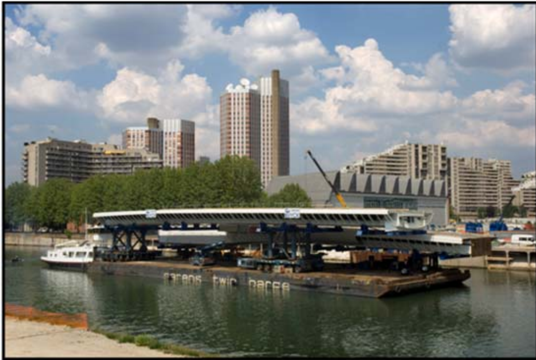
Photo 6 : transport sur barge des travées 2 et 3 (avril 2007)
