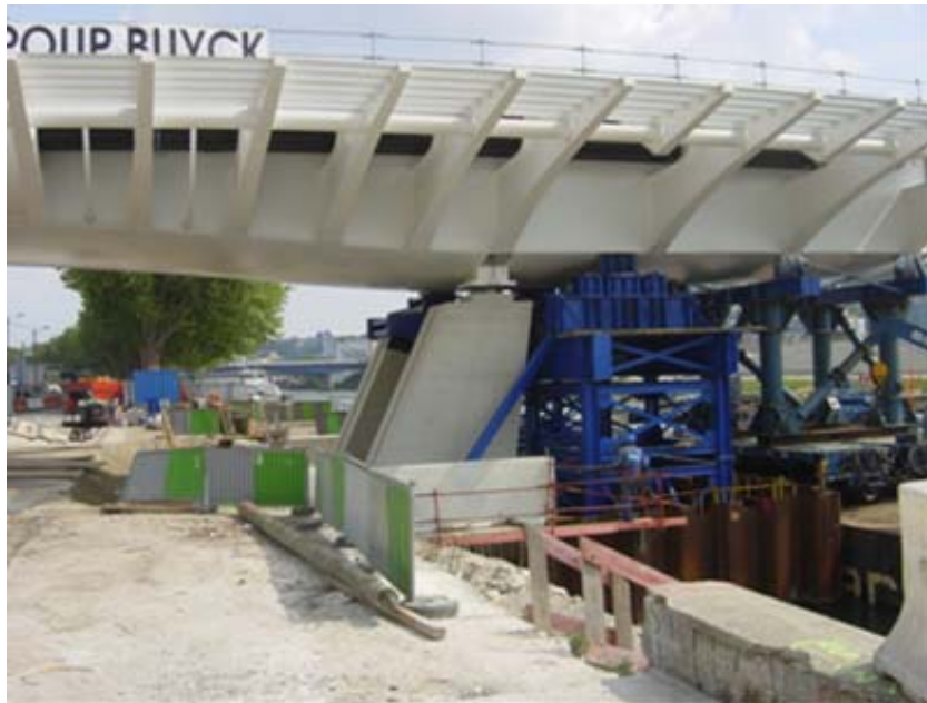
Photo 2 : Variation des larges encorbellements
