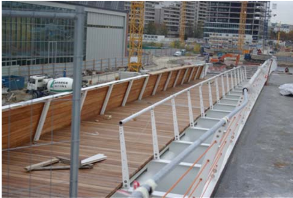
Photo 4 : Les superstructures en cours de montage
