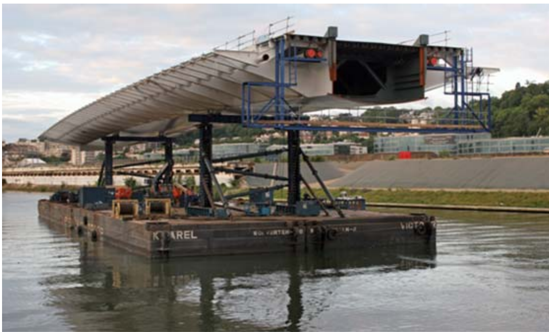
Photo 7 : Pose du tronçon sur la Seine (Juin 2007)
