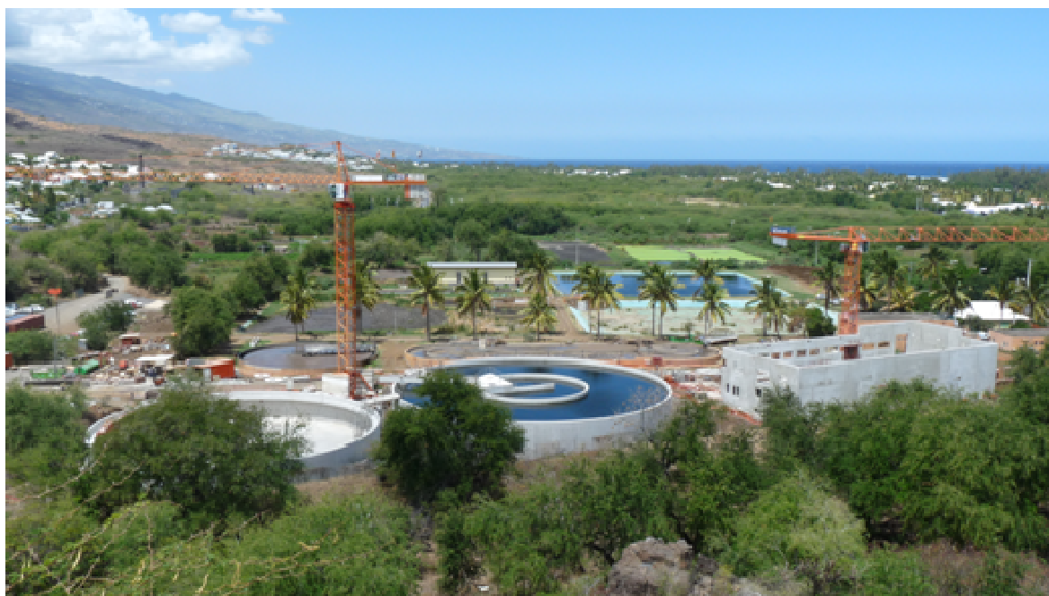
Station de l'Ermitage
