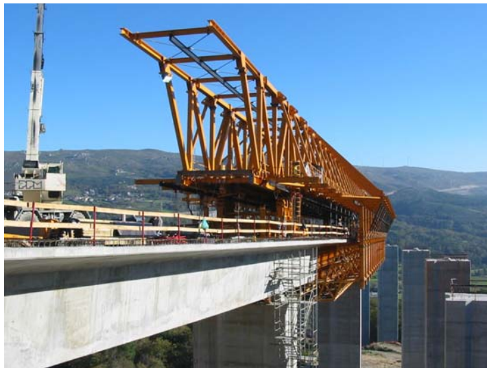
Cintre autolanceur côté Nord
