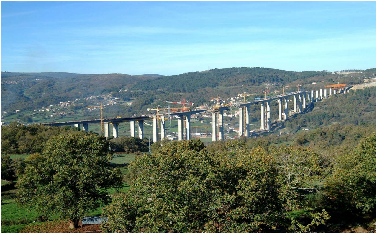
Vue d'ensemble en cours de construction
