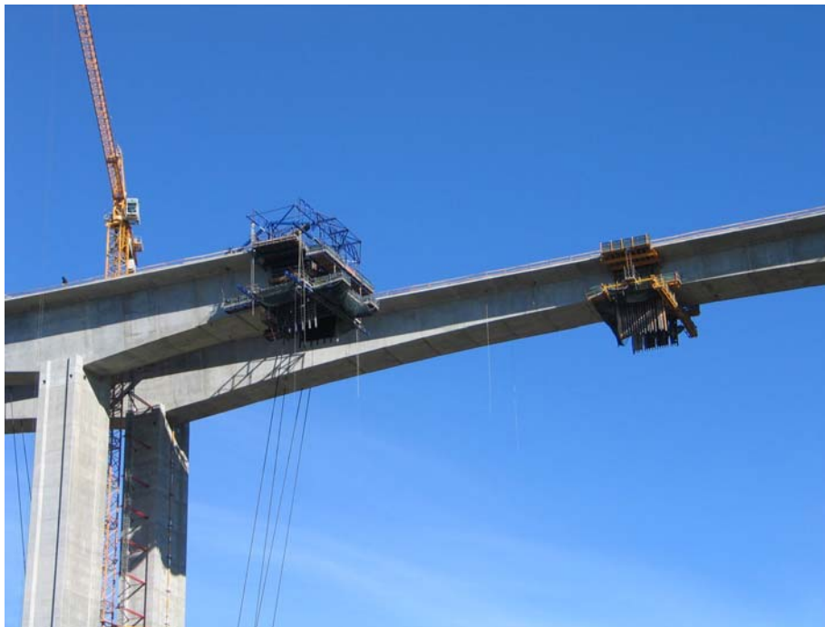
Bétonnage et clavage des tabliers
