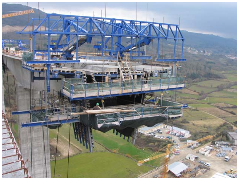
Equipage mobile de bétonnage
