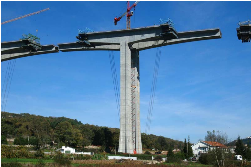
Haubanage provisoire des piles
