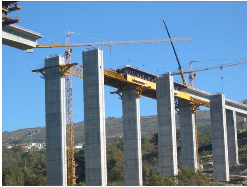
Cintre autolanceur côté Sud
