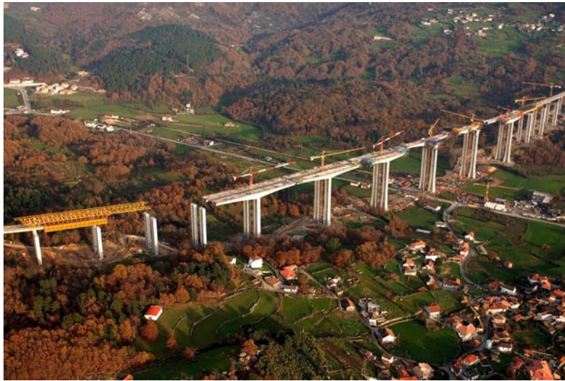
Photo 1 : Vue d'ensemble en cours de construction
