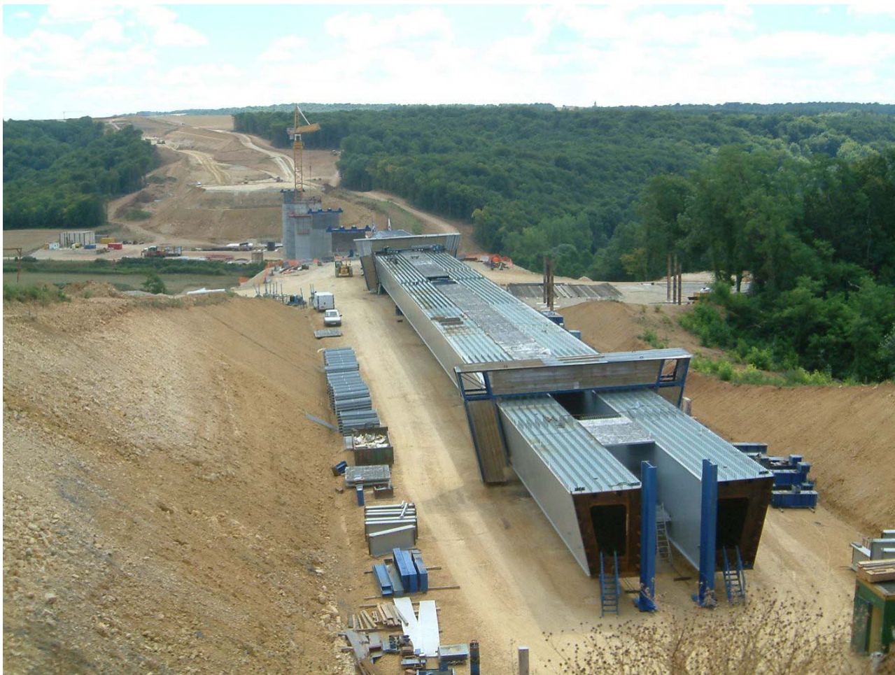
Photo 1 : Déblai Ouest et installation d'assemblage et de poussage
