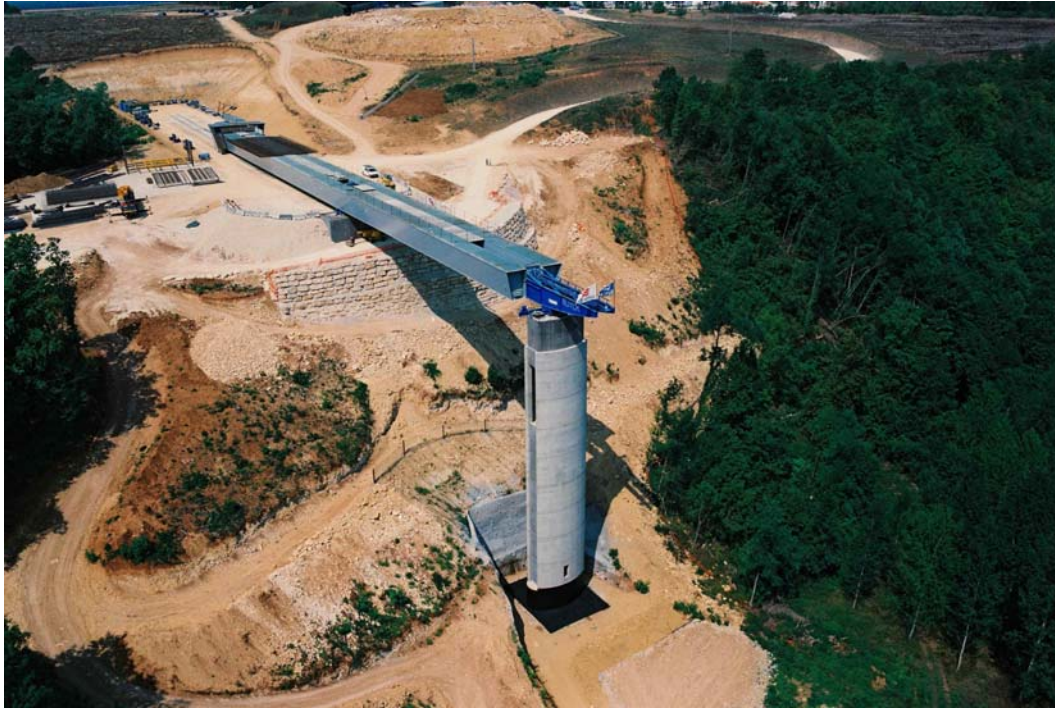
Photo 2 : Mur de soutènement en enrochements – talus Ouest - pile P1 avec paroi clouée
