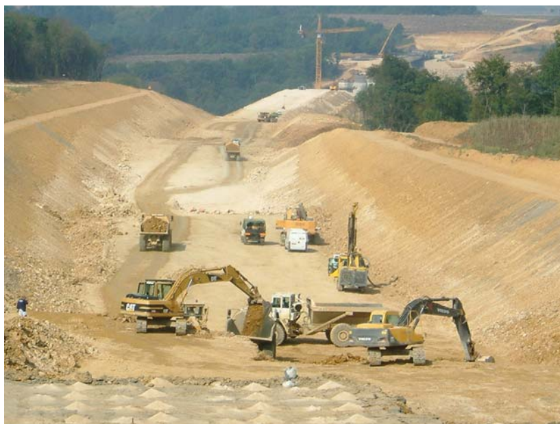
Photo 3 : Déblai remblai Est
