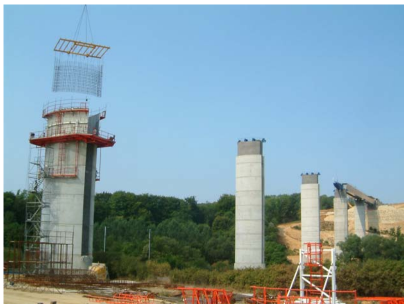
Photo 4 : Coffrage grim pant sur pile P5
