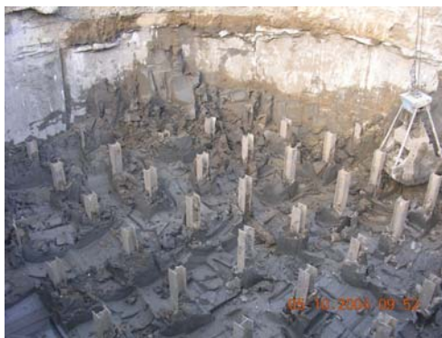
Renforcement des argiles par inclusion d'HEA 300 Clay reinforcement with steel : HEA 300
