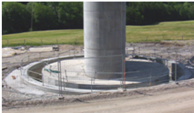
Fondation de la pile P5 une fois terminée / Final foundation of P5
