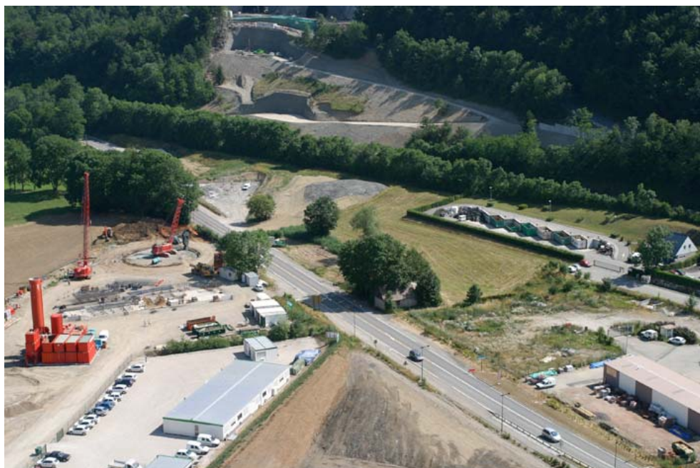
Vues d'ensemble de la plate-forme P3-P4, avec P3 en cours de terrassements View of P3-P4, with P3 during excavation
