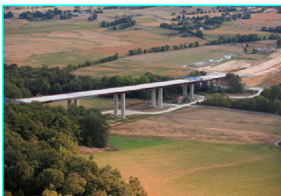
Viaduc du Gabas
