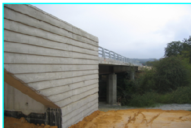
Viaduc du Luy sur France
