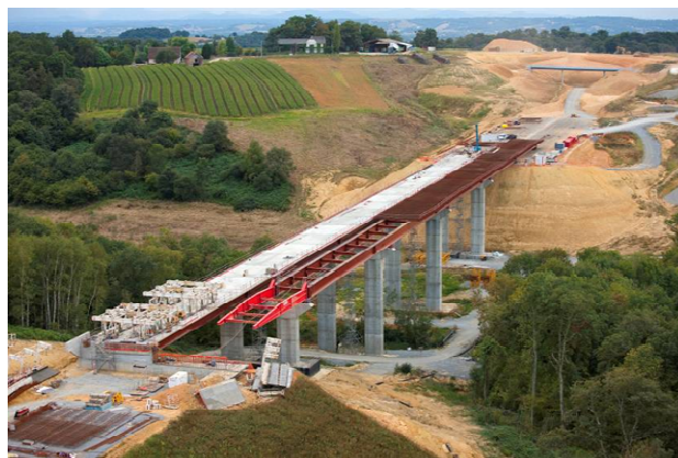
Viaduc du Riumayou
