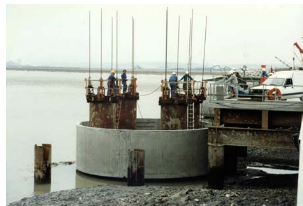
Photos 3: Pont de Normandie Jacking of pile caps / Vérinage des semelles de piles
