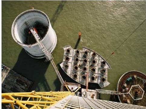
Photo 6 : Gabion prêt pour descente Pier-protection cell ready for lowering
