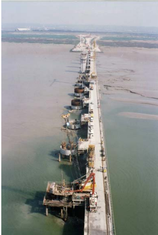
Photo 2 : Pont de Normandie Viaduc Nord - Construction des fondations Northern approach viaduct – Foundation construction
