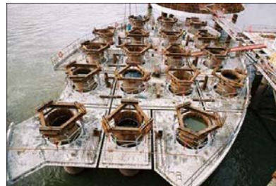
Photo 4: Pedestal – Assembly of precast units Socle – Assemblage des éléments préfabriqués
