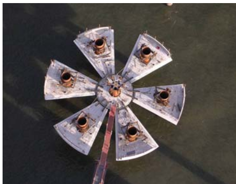
Photo 5 : Gabions de protection - Assemblage des "pétales" en béton armé / Pier-protection cells - Assembly of reinforced-concrete units
