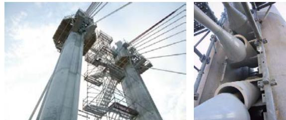
Photo 16 : Réglage définitif des haubans depuis les têtes de mâts / Final adjustment of the stays from the tops of the masts
