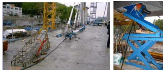
Photo 12 : Mise en tension des haubans avant rotation depuis la sous-face du tablier / *Tensioning of the stays before rotation from the underside of the deck*
