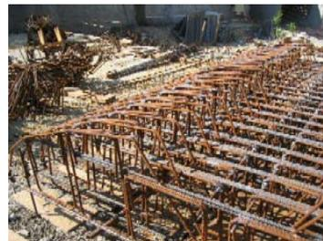
Photo 9 : Cage d'armature d'une levée de pylône (ratio d'acier :  $137 \text{ kg/m}^3$ ) / Reinforcement cage for one lift of the pylon (steel content :  $137 \text{ kg/m}^3$ )
