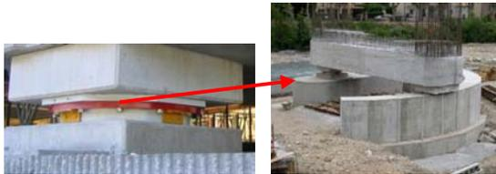
**Photo 4 : Positionnement de l'entretoise sous pylône avant rotation et détail de la couronne de guidage / Positioning of the crossbeam under the pylon before rotation and detail of the guide crown**
