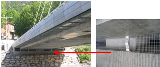
Photo 15 : Butée parasismique de blocage latéral en culée rive gauche et grillage anti-intrusion / Seismic stopper against lateral movement on the left bank abutment and intruder-resistant barrier
