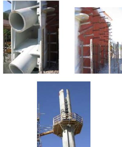
Photo 10 : Boîtes d'ancrage métalliques des haubans / Cable stay anchor metal boxes
