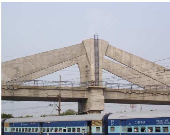
Figure 16. Pragati Maidan - Pont à précontrainte extradossée
