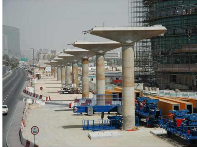
Figure 18. Métro de Dubai - piles et chevêtres
