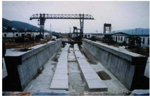
Figure 7. Guangzhou ligne n° 2 – Travée d'essai
