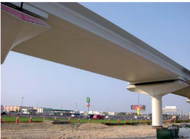
Figure 19. Métro de Dubai – Travée type
