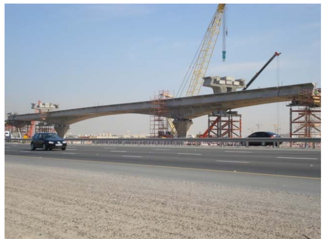
Figure 20. Métro de Dubai – Travée de hauteur variable
