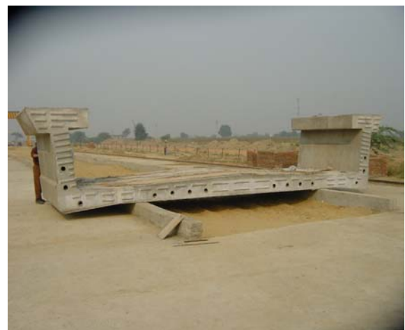
Figure 13. Viaduc de la ligne n° 3 de Delhi Voussoir préfabriqué
