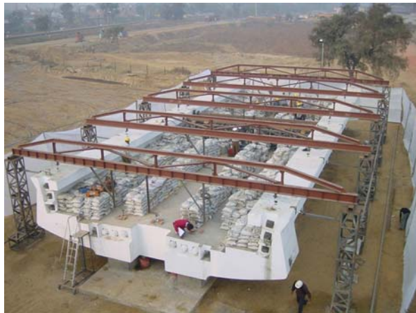
Figure 14. Delhi ligne n° 3 – Travée d'essai
