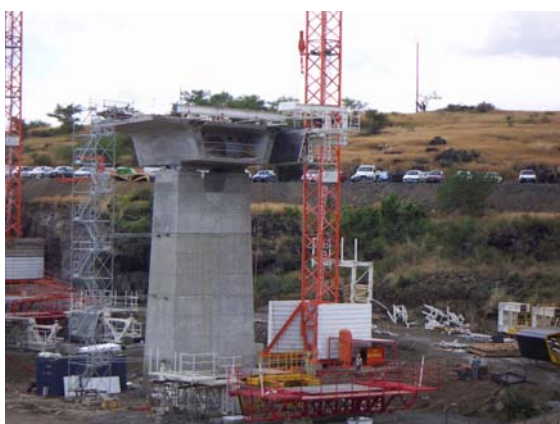
Photo 7 : Montage des équipages mobiles. Mounting the formwork travellers
