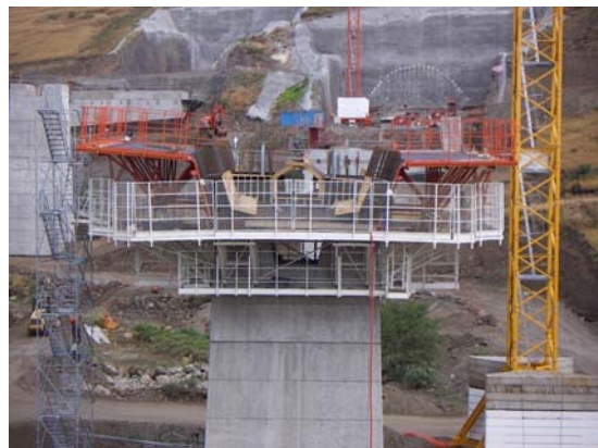
Photo 5: Platform and external formwork of the pier segment / Plateforme et coffrage extérieur du voussoir sur pile
