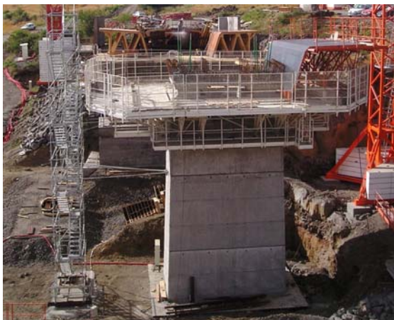
Photo 4 : Pose de la dalle préfabriquée servant de fond de coffrage du voussoir sur pile au droit de l'entretoise / Laying of the prefabricated slab serving as the formwork bottom of the segment on pile right below the staying cable
