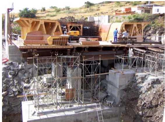
Photo 10: Reinforcement of a part on falsework. Ferrailage d'une partie sur cintre du tablier
