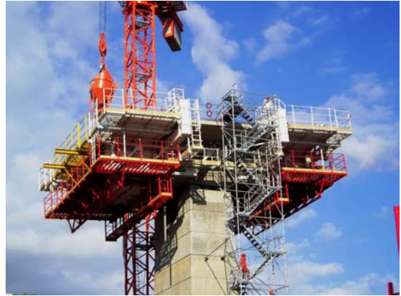
Photo 8: Cantilever construction. Fléau en cours de construction
