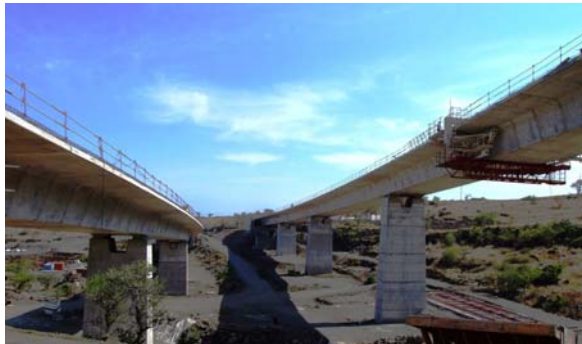
Photo 11: Vues d'ensemble du viaduc de Fleurimont à la fin de la construction du tablier. Overall views of the Fleurimont Viaducts at the end of the deck construction.
