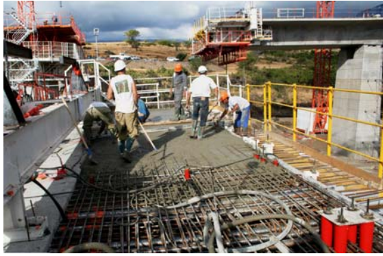
Photo 9 : Bétonnage d'un voussoir. Concreting a segment
