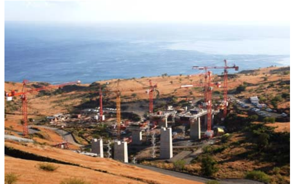
Photo 3: Overall view of the worksite Vue d'ensemble du chantier
