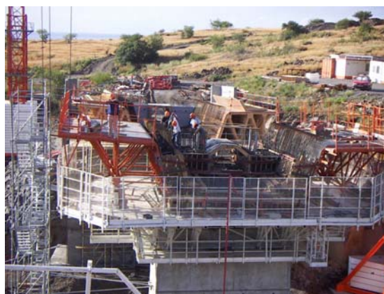
Photo 6: Reinforcement of a pier segment. Ferrailage d'un voussoir sur pile
