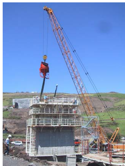
Photo 1: Construction of a pier Réalisation d'une pile
