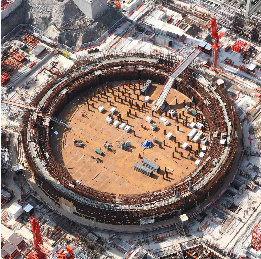
Bassine de l'embase du bâtiment réacteur
