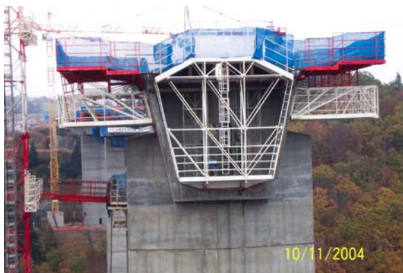
En tête de pile, outil et plate-forme frontale d'un VSP avant réalisation du hourdis supérieur.
