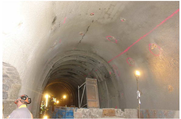
Le tunnel de Ponte-Rotto
