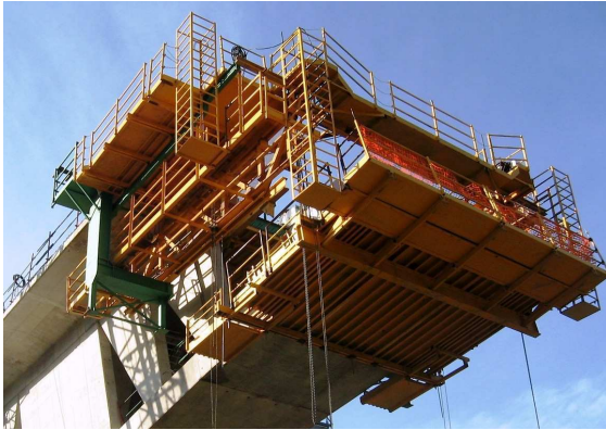
Coffrage d'un voussoir courant
