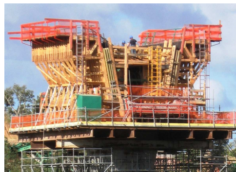
Coffrage d'un VSP
