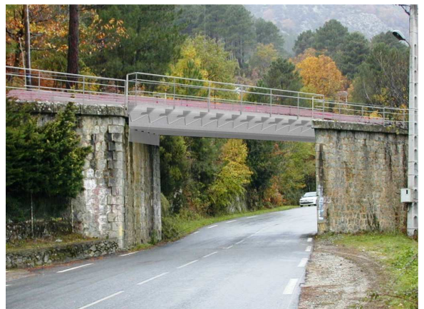
Pont rail de Venaco sur la RN 193
