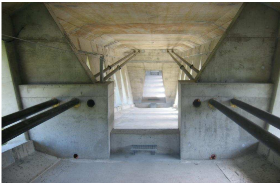
La précontrainte dans le caisson
