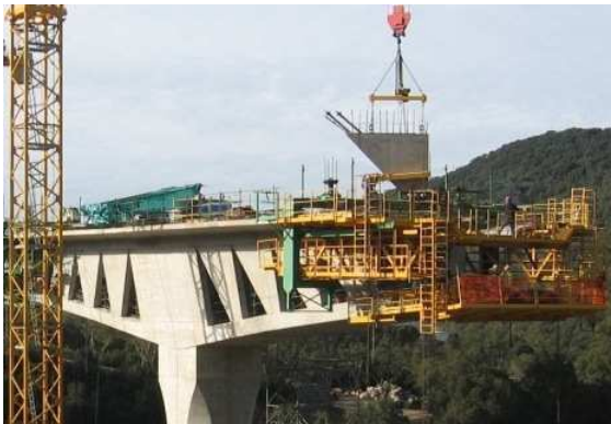
Mise en place des âmes préfabriquées
