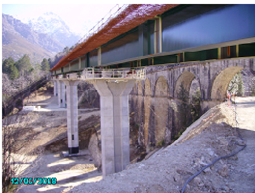
Le viaduc en cours de réalisation
