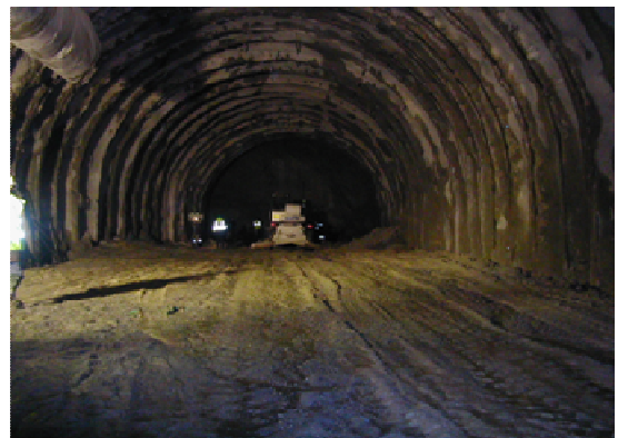
Le tunnel en cours de réalisation
