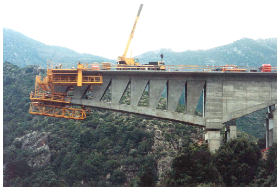
Construction du fléau
