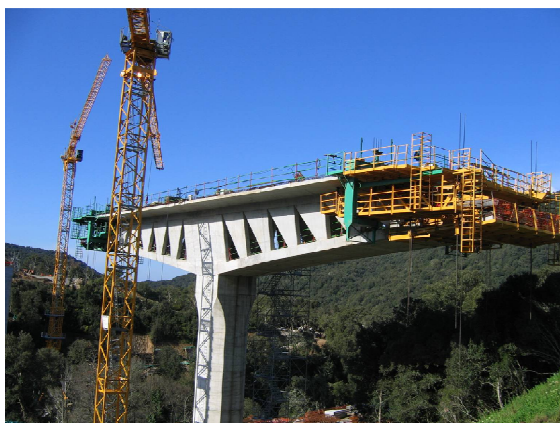
Construction du fléau
