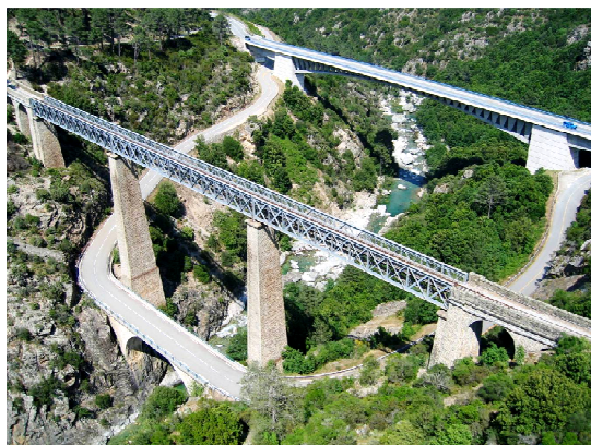
Pont du Vecchio
