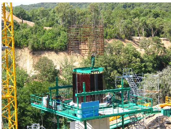
Ferrailage des piles
