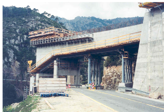
Coulage de la travée de rive
