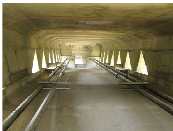
Intérieur de la travée centrale
