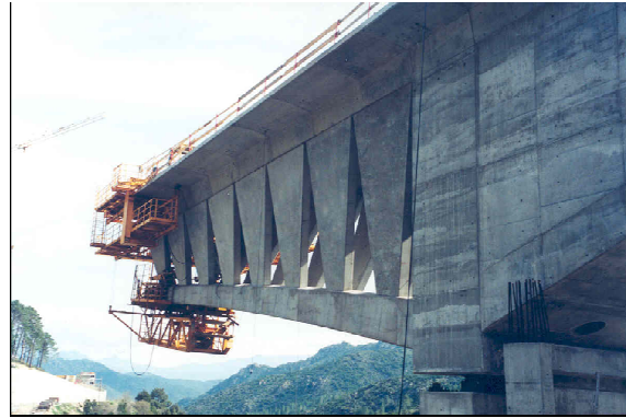
Pont du Vechio - Phases de construction
