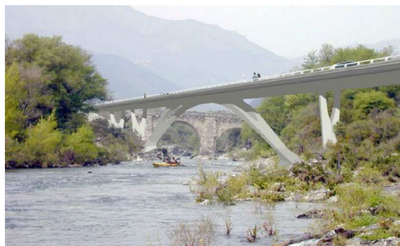
Le nouveau pont d'Altiani Lavigne-Chéron Architecture ©
