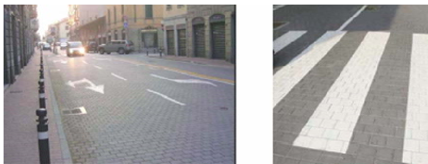
Figure 1 : Via Borgo Palazzo, après rénovation
