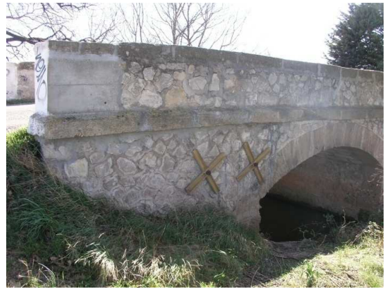
OA 27 - Pont voûte en maçonnerie
