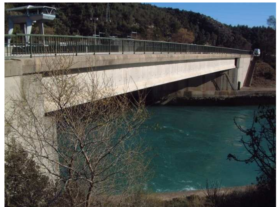
OA 32 - Pont à poutres précontraintes (VIPI)
