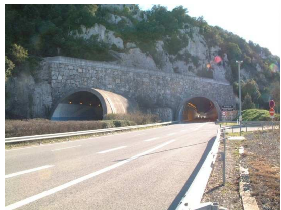
OA 34 - Tunnels en béton armé avec mur de soutènement
