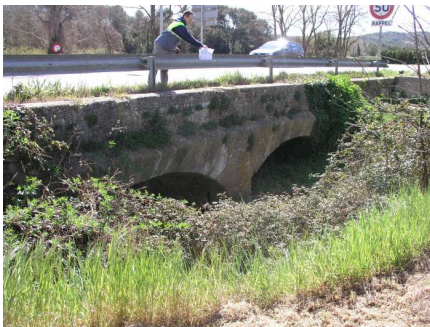
OA 1R7 - 4 voûtes en maçonnerie
