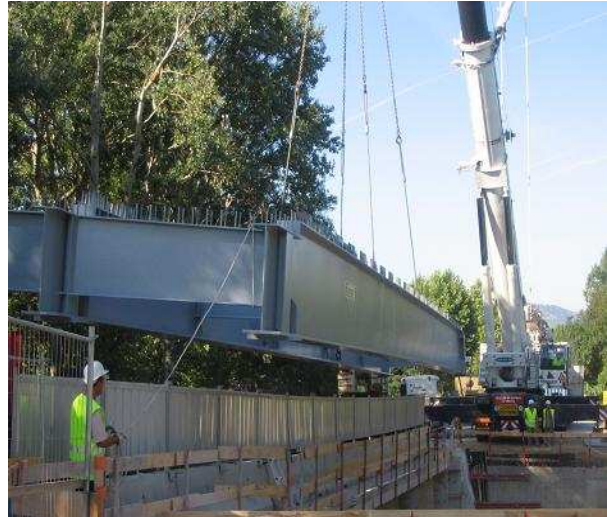
Pose de la charpente métallique du demi-tablier du nouveau pont le 30 août dernier
