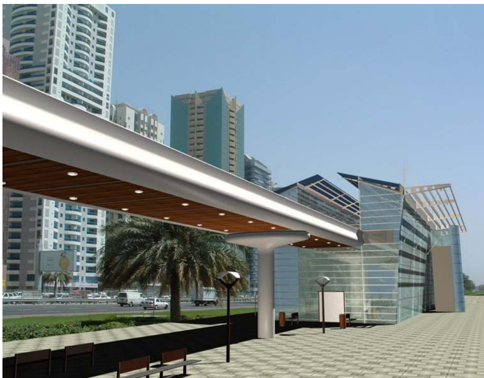
Fig. 10 Dubai metro viaduct Viaduc du métro de Dubaï
