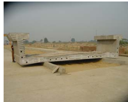
Fig. 9 Delhi DD3B viaduct – Precast segment Delhi DD3B – Voussoir préfabriqué
