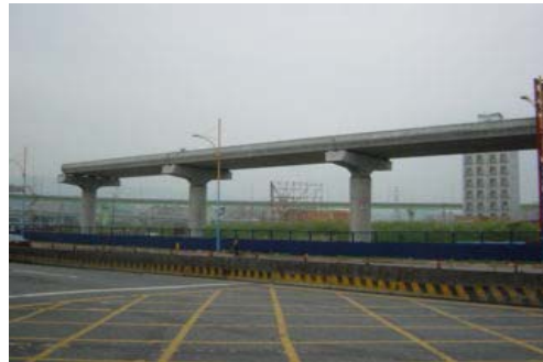
Fig. 3 Neihu metro line – General view Ligne de métro de Neihu – Vue Générale
