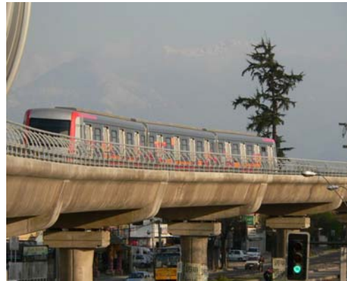
Fig.6 Santiago metro line n° 4 – General view Ligne n°4 du métro de Santiago – Vue générale
