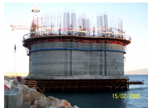
Fig 12: Caisson before floating / Caisson avant la mise à l'eau
