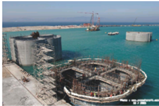
Fig 13: 2 nd stage of precast / 2 ème phase de bétonnage
