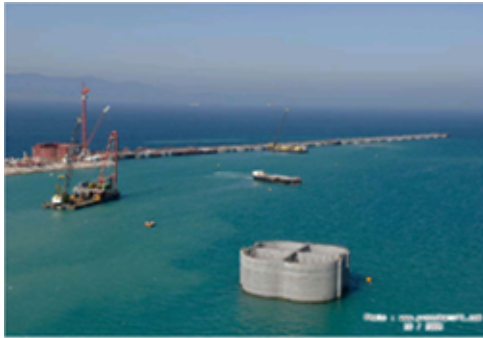
Fig 14 : Remorquage du caisson / Towing a caisson
