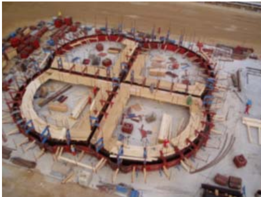
Fig 9 : Montage du coffrage glissant / Placing sliding formwork
