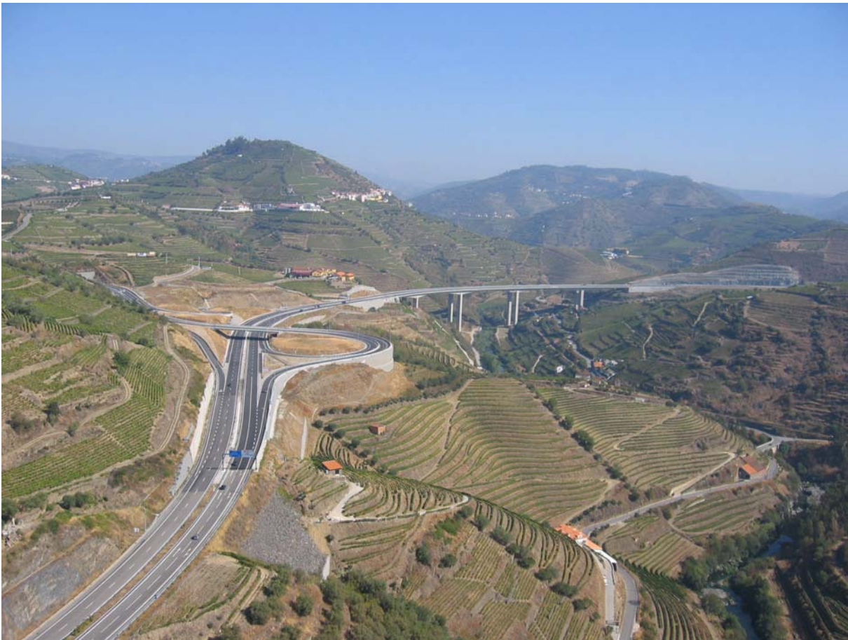
Photo 2 : Construction des tabliers au cœur des Vignobles de Porto Construction of decks amidst Porto wine vineyards
