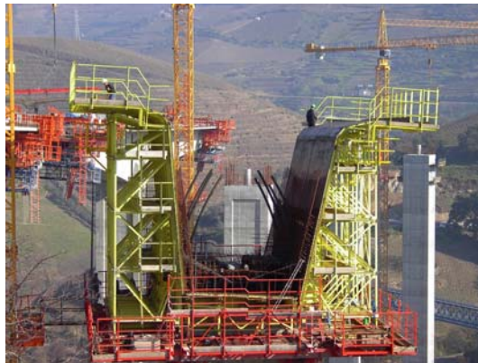
Photo 3: Segment on pier formwork under erection Coffrage d'un voussoir sur pile en cours de montage
