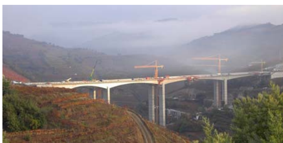
Photo 4 : Construction des fléaux en encorbellement au-dessus du Rio Corgo Construction of cantilevers above Rio Corgo
