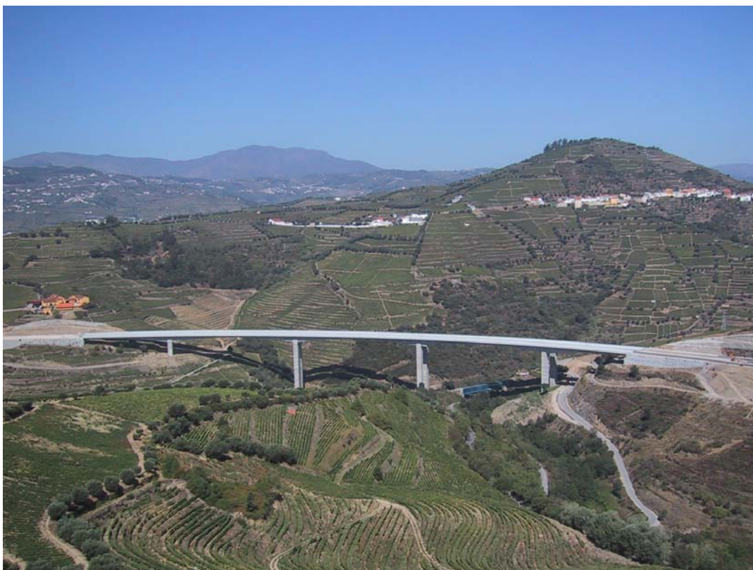
Photo 1 : Vue générale de l'ouvrage / Corgo River Bridge
