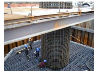
Photo 4 : Ferrailage des zones de rotules plastiques ( \approx 340 \text{ kg/m}^3 ) / Detailing in potential plastic hinge zones ( \approx 340 \text{ kg/m}^3 )
