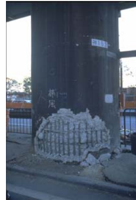
Photo 3 : Formation de rotule plastique / Example of plastic hinging (Kobe, 1995)
