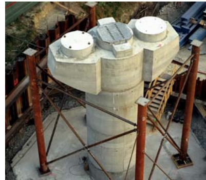
Photo 6 : Pile P1, chevêtre et bossage pour butée transversale / Pier P1, pier capbeam and bearing cap for transverse stopper
