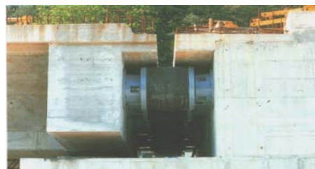
Photo 2 : Amortisseurs longitudinaux sur le Viaduc de Fella (Italie) / Longitudinal dampers on the Fella Viaduct (Italy)
