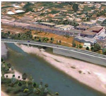
Figure 3 : Vue aérienne de l'ouvrage côté C6 et du mur M1 (photomontage) / Aerial view of the bridge at abutment C6 and wall M1 (photomontage)
