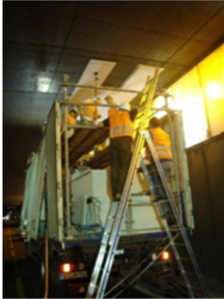
*Figure 23 : Mise en place de la protection au feu*
