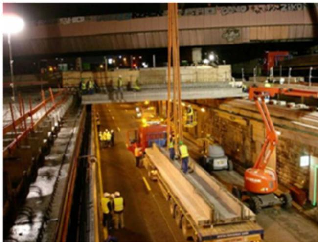
*Figure 7 : Pose des poutres de nuit*
