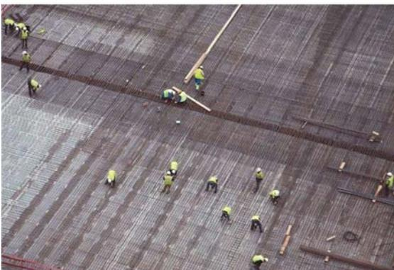
Figure 10 : Mise en place du ferrillage du hourdis
