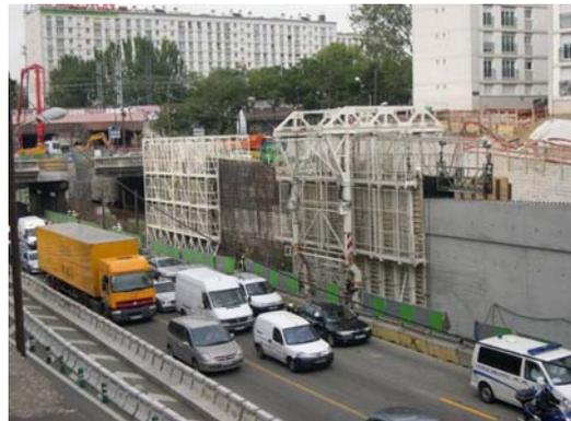
Figure 11 : Portiques de ferrillage et coffrage du mur en TPC
