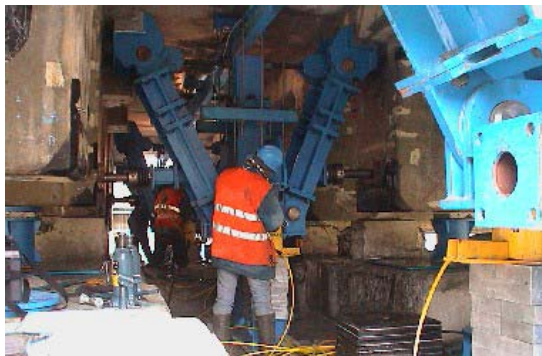
Fig 9. Fin des opérations de levage avec le dispositif de levage End of the lifting operations with the lifting device
