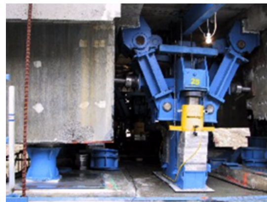
Fig 5. Lifting device on intermediate piers. Dispositif de levage sur piles intermédiaires. Shortest configuration after 50cm lifting. Configuration la plus basse après 50 cm de levage
