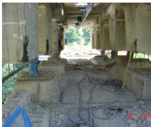
Fig 11. Dessus de pile après retrait des anciens blocs afin de faciliter les travaux de réparation et de renforcement
