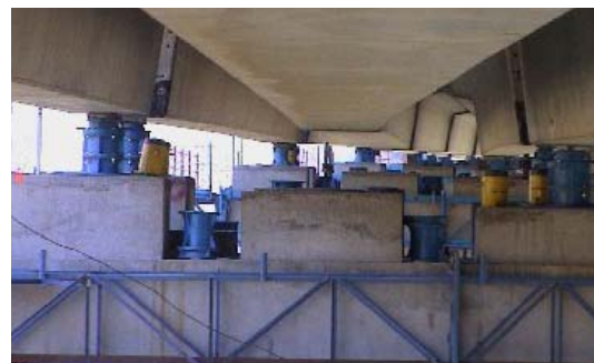
Fig. 10. After works situation, as seen from under the beams / Situation après les travaux, vue du dessous des poutres
