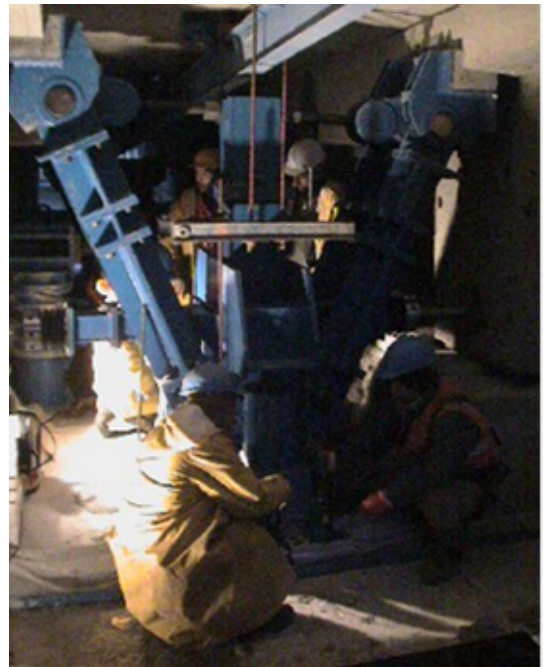
Fig 6. End of the loading of the device. During the loading itself, a minimum of 2 people attended each lifting device. Fin de la mise en charge du dispositif Au cours de la mise en charge proprement dite, au moins deux personnes s'occupaient de chaque dispositif de levage.
