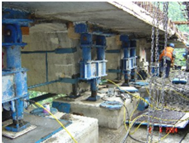
Fig 4. Opération de levage sur une pile en extrémité de segment Lifting operation on an expansion joint pier
