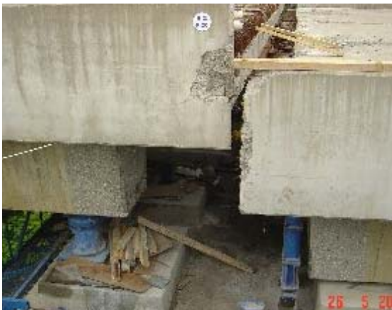
Fig 10. Différence de niveau avant levage / après levage en extrémité d'élément Difference of level between after lifting and before lifting at a segment end
