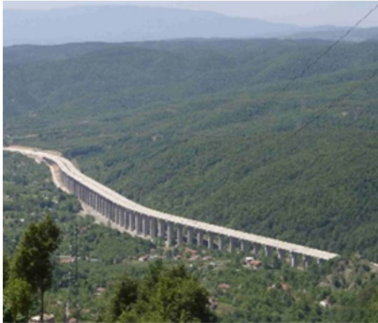
Fig 1. Vue d'ensemble du tablier double / General view of the twin deck
