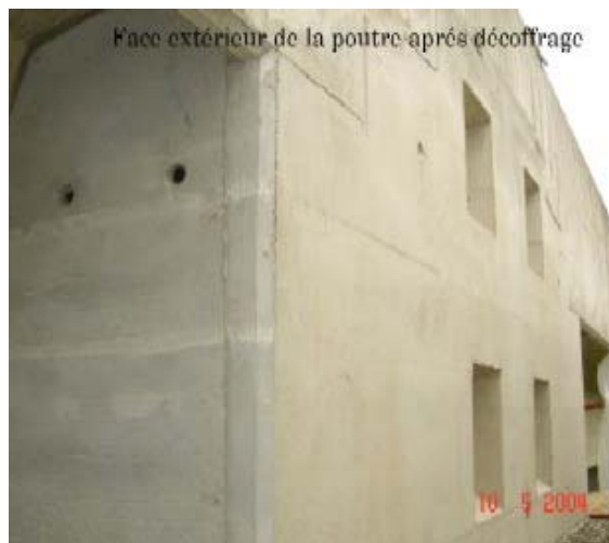
Fig 16. Bétonnage du béton sur la maquette (en haut à gauche). Bétonnage in situ (en haut à droite et en bas à gauche) : parement du béton après décoffrage (en bas à droite)
