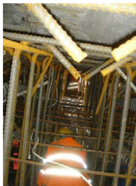
Fig 15. Détails du ferrailage : barres scellées mises en place en premier (en haut à gauche) ; armatures inférieures mises en place, puis cadres principaux et armatures dans les extensions mis en place lors d'une deuxième étape (en haut à droite) ; troisième étape de la mise en place des armatures : étriers ou cadres secondaires (en bas à gauche) ; dernier contrôle des armatures avant bétonnage, les gaines de précontrainte (en bas à droite) ont été mises en place et liées au ferrailage.
