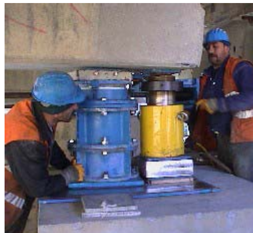
Fig 9. Last shimming: the lifting operations are now over (sandbox is placed at the top of the shims for load transfer purpose after the concreting) Calage final : les opérations de levage sont maintenant terminées (boîte à sable placée sur le dessus des cales pour permettre le transfert de charge après bétonnage de l'entretoise).
