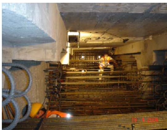
Fig 15. Détails du ferrailage : barres scellées mises en place en premier (en haut à gauche) ; armatures inférieures mises en place, puis cadres principaux et armatures dans les extensions mis en place lors d'une deuxième étape (en haut à droite) ; troisième étape de la mise en place des armatures : étriers ou cadres secondaires (en bas à gauche) ; dernier contrôle des armatures avant bétonnage, les gaines de précontrainte (en bas à droite) ont été mises en place et liées au ferrailage.
