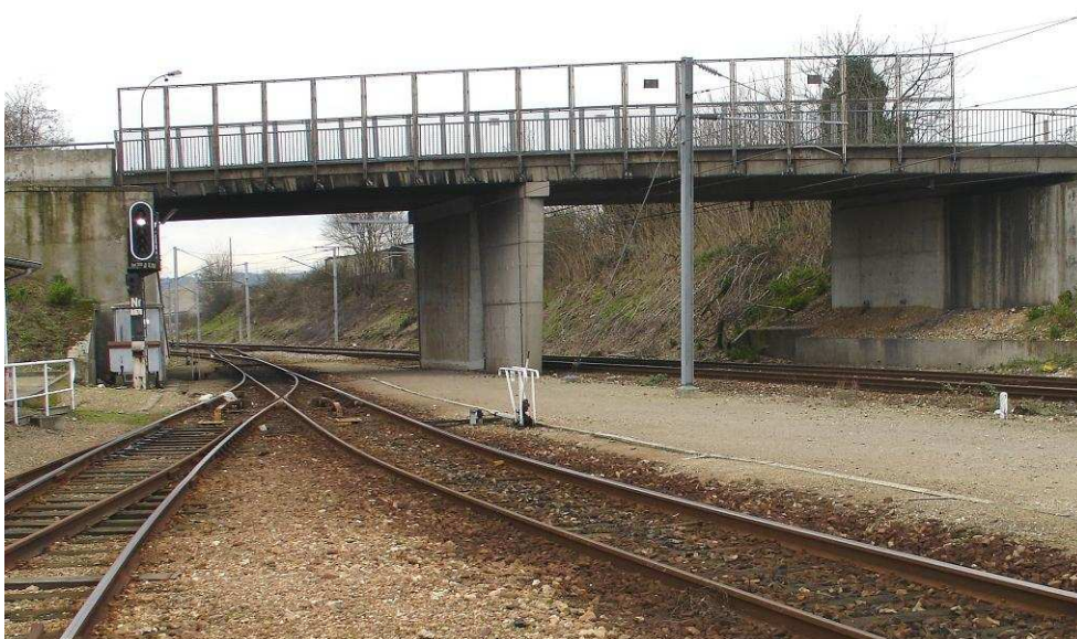
Photo 3 : Pont Pinel - Vue générale de l'ouvrage existant
