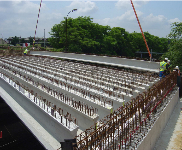
Photo 4 : Pose des poutres
