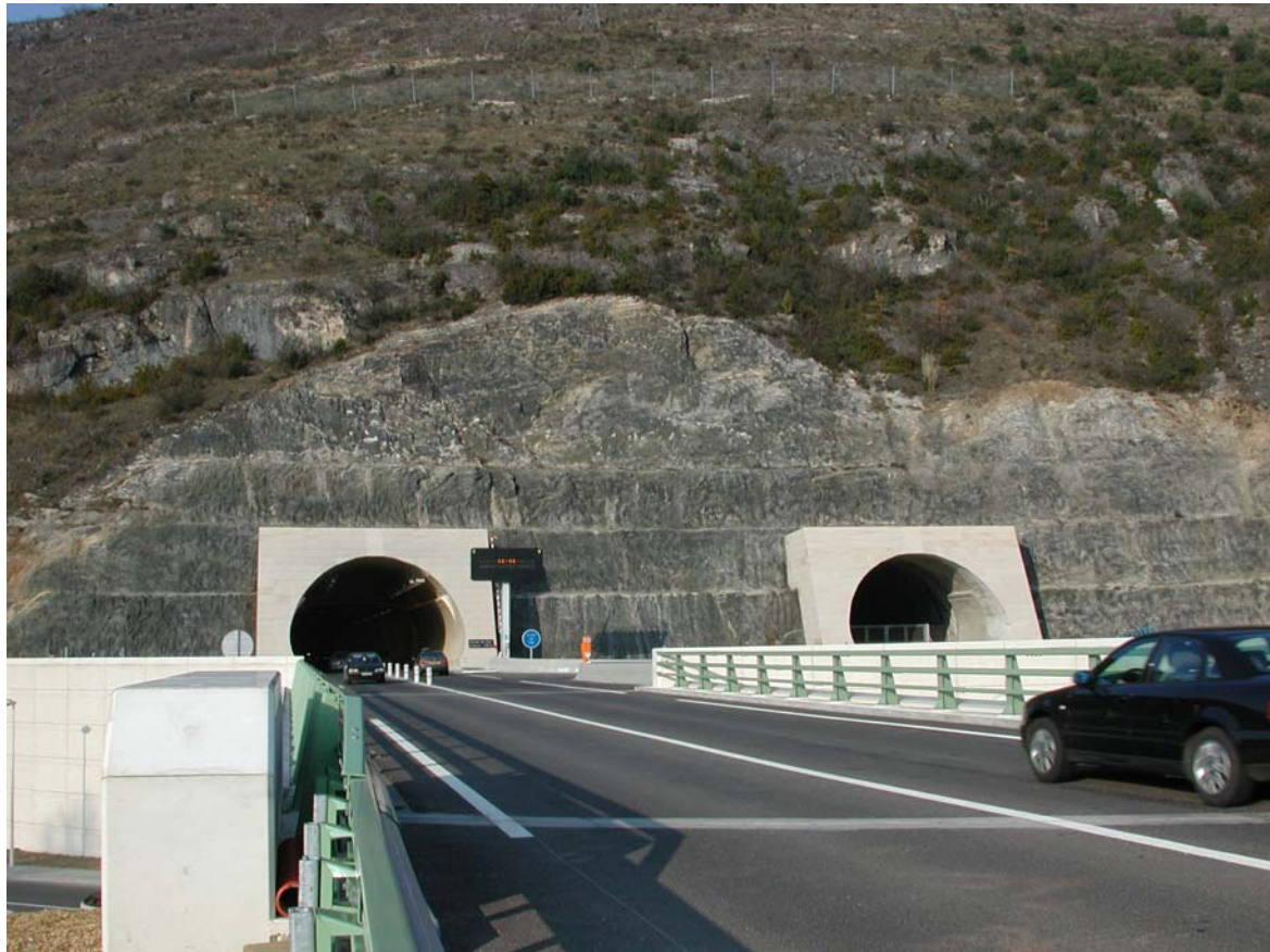
Têtes sud et ouvrages d'accès / Southern portals and approach bridge
