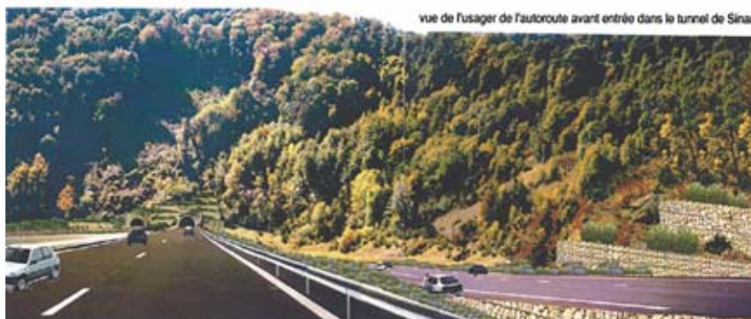
vue de l'utilisateur de l'autoroute avant entrée dans le tunnel de Sinard
