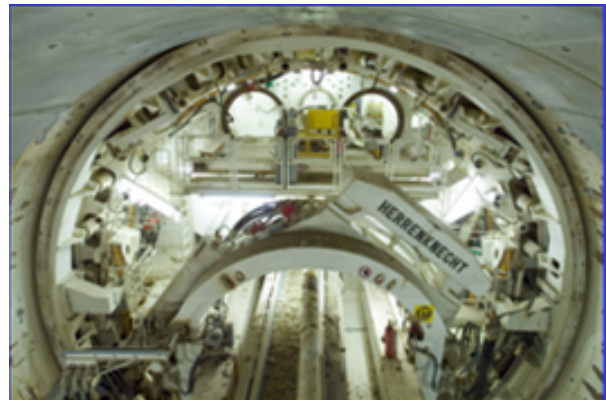
Photo transversale du tunnelier
