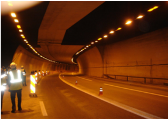
Tunnel de MONACO (bretelle de l'A500)
