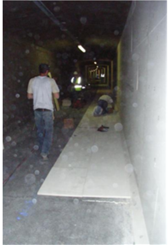
Aménagement de la galerie d'évacuation
