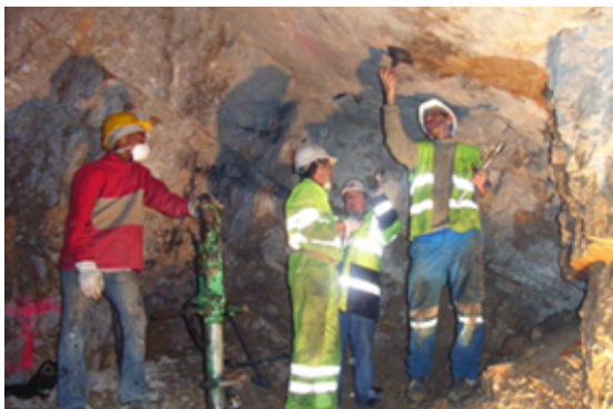
Creusement de la galerie de liaison
