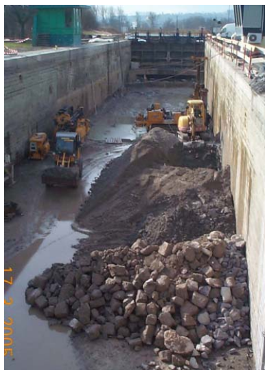
Décaissement des zones amont et aval du radier
