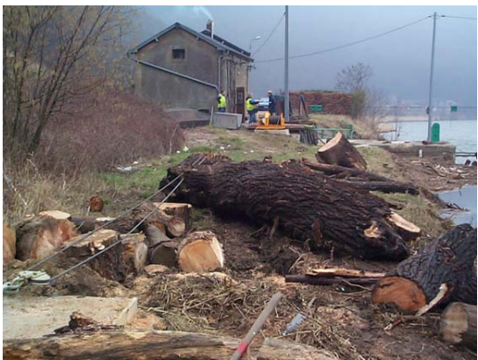
Autre aléa sur un barrage : les arbres
