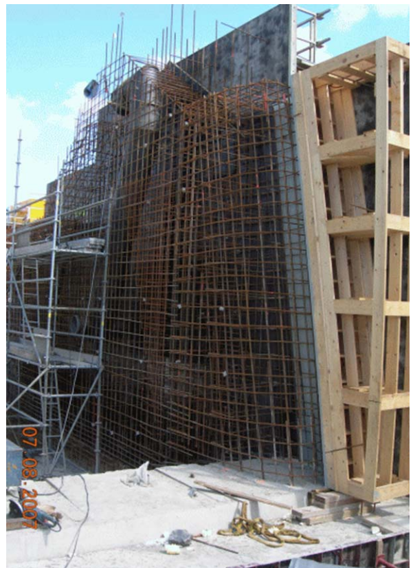
Réalisation des piles
