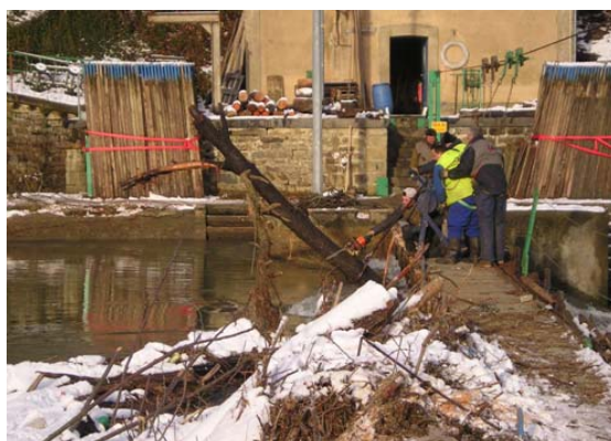
Nettoyage à faire quelles que soient les conditions climatiques
