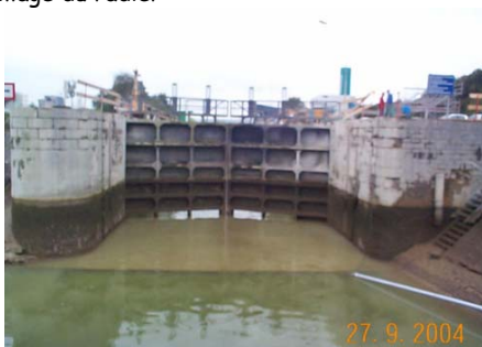
Mise en eau de la première tranche
