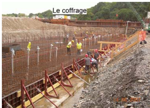
Réalisation des seuils amont et aval
