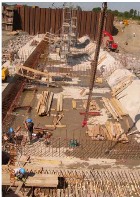
Réalisation des seuils amont et aval
