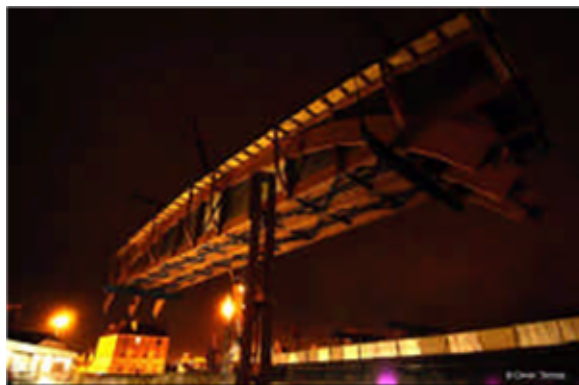
Passerelle de Vaires-sur-Marne conçue par SNCF Ingénierie - Bernard Rey architecte (photo Olivier Thomas)
