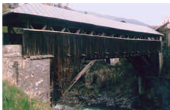
Pont couvert du 18 e siècle toujours régulièrement entretenu et encore en service aujourd'hui. Photo : Jacques Berthelley
