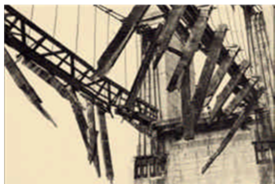
Tablier de pont suspendu en bois mal protégé après le passage d'un poids lourd ne respectant pas la limitation de tonnage. Photo : Cete de Lyon
