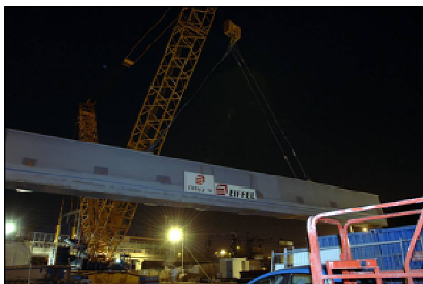
Deuxieme livraison et levage sur site en rive droite
