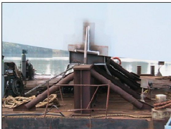
Fixations des poutres sur la barge pour le transport fluvial et maritime
