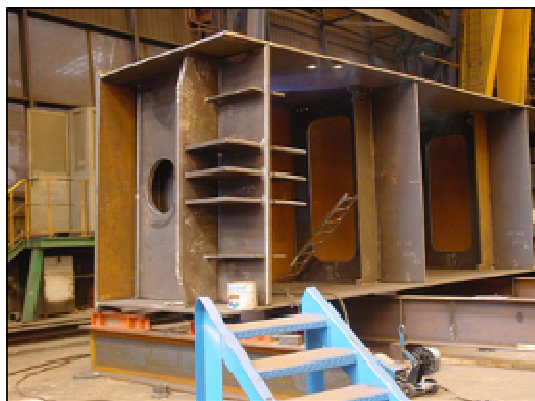
Poutre centrale sur appui
