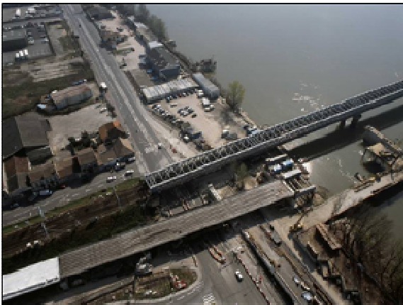
Coté Pc1: Tronçon T1-1
