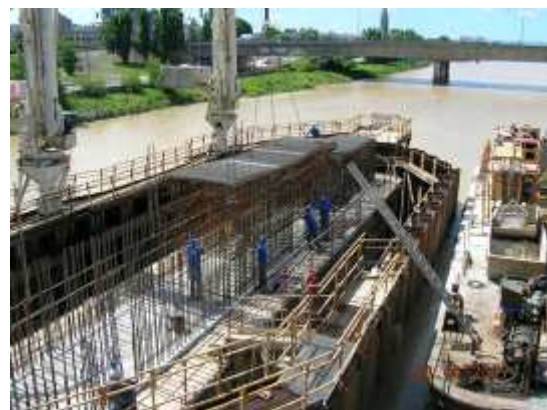
Le point fixe du viaduc (pile P6)
