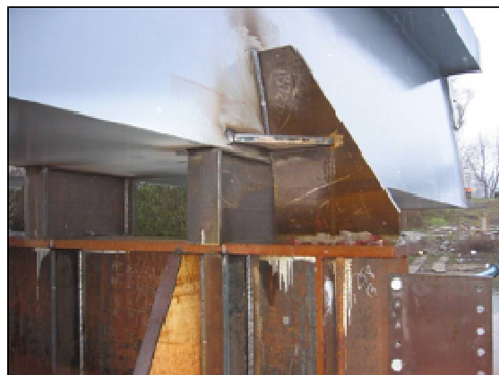
Fixations des poutres sur la barge pour le transport fluvial et maritime
