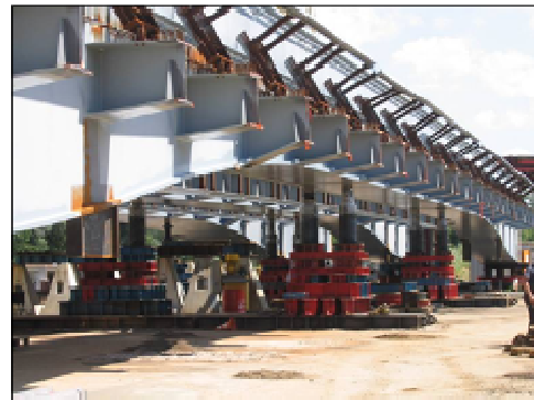
Assemblages et verinages sur plateforme
