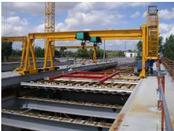
Préfabrication des paniers
