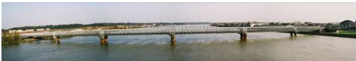
La « passerelle » existante
