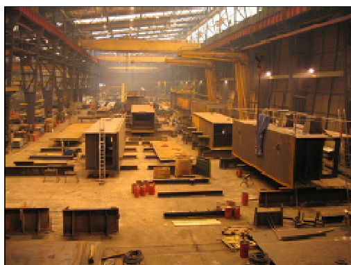
14 tronçons en cours d'assemblage dans 2 halls
