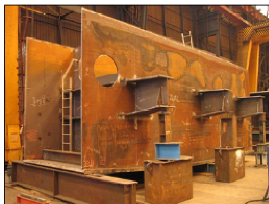
Poutres centrales courantes en cours d'assemblage
