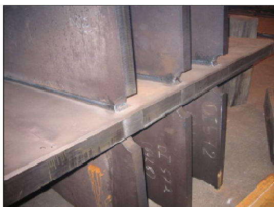
Raidisseurs d'appui d'ép. 100mm après passe mécanique
