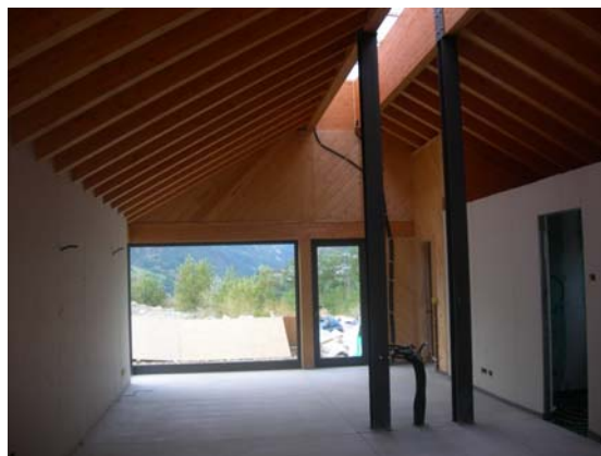
Figure 4 Construction utilisant le bois ainsi qu'un puit de lumière
