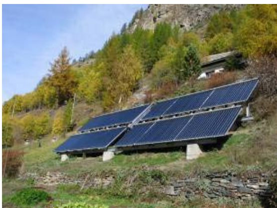
Figure 2 - Intégration de panneaux solaires en s'appuyant sur les pentes naturelles du paysage
