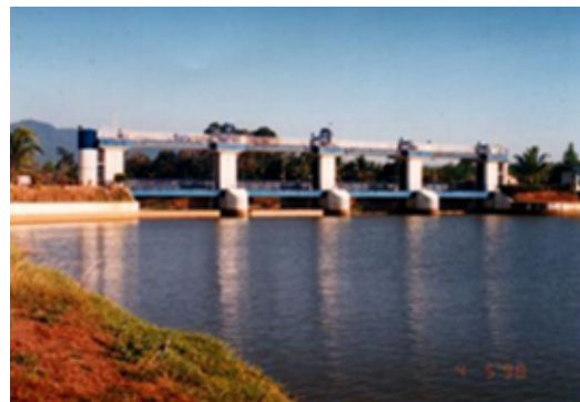
Barrage au fil de l'eau
