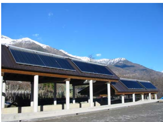
Figure 3 - Une bonne intégration des panneaux, qui définissent la l'inclinaison de la toiture
